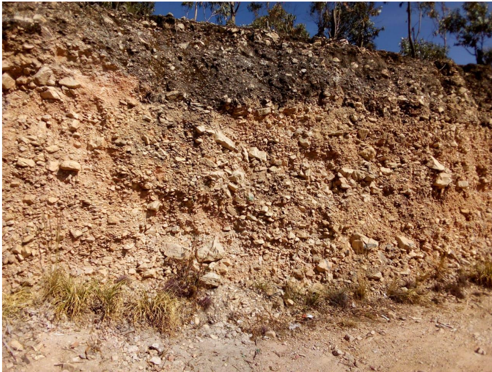
Figura 8. Representación de la meteorización físico – química que existe cerca los límites de la cantera Aylambo.
