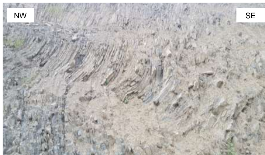
Figura 19. Plegamientos de calizas de la Fm. Pariatambo, debido a la compensación de materiales producto del deslizamiento.
