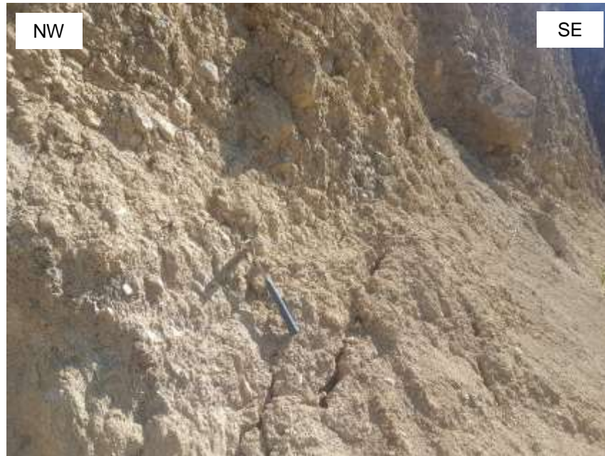
Figura 24. Grietas en la parte superior del talud.
