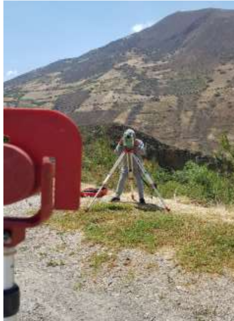
Figura 47. Levantamiento topográfico del talud.
