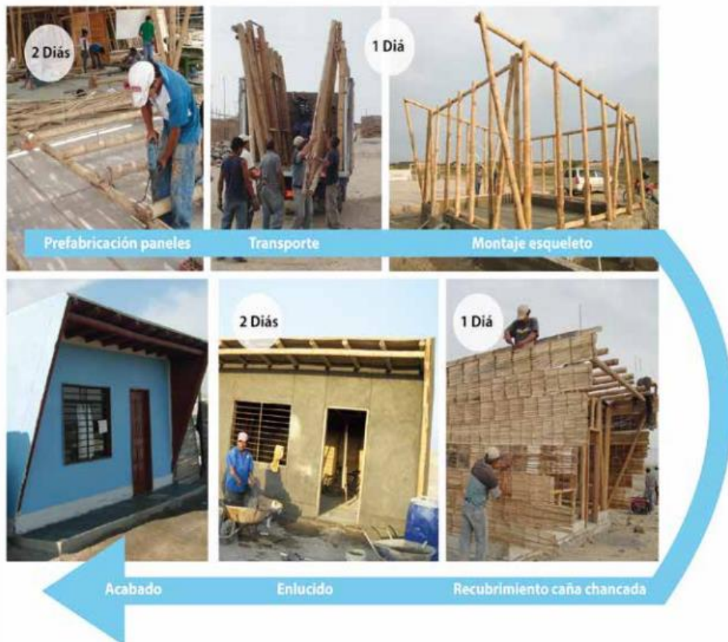
Figura 1. Proceso de Construcción del Módulo de Vivienda de 22 m 2 .
