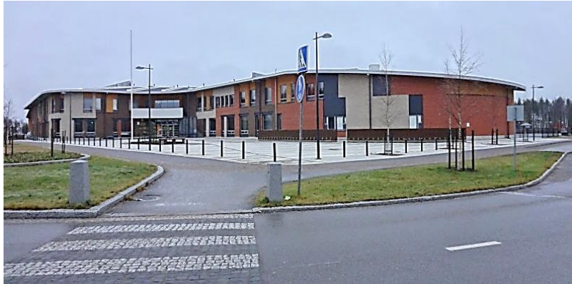
Fig. 35: Vista de la fachada del Colegio.
