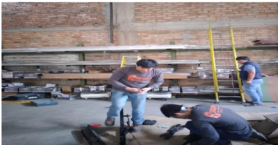
Figura 9: No cuentan con documentación que les facilite evaluar peligros, riesgos y considerar las medidas de control. Así mismo, como puede apreciarse en la figura, trabajan sin EPPs adecuados.
