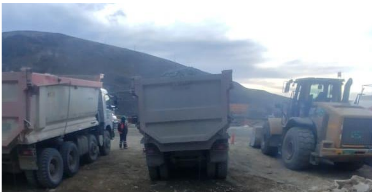
Figura 2 Equipos de la empresa – Proyecto San Rafael
