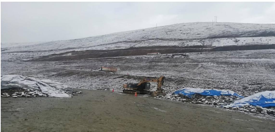
Figura 5 Excavadora de la empresa COMIN SAC
