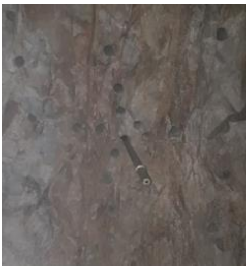
Arranque de la malla de perforación empírica
