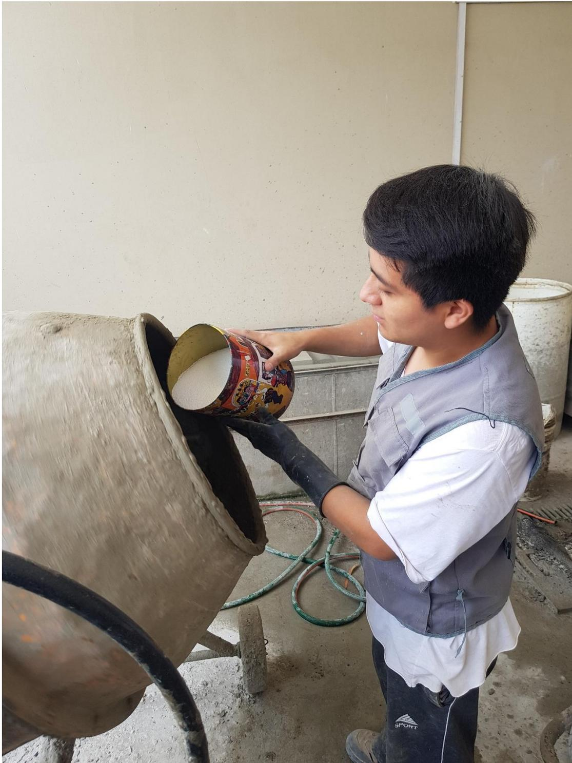
*Figura 38:* Mezcla del concreto con microperlas de poliestireno
