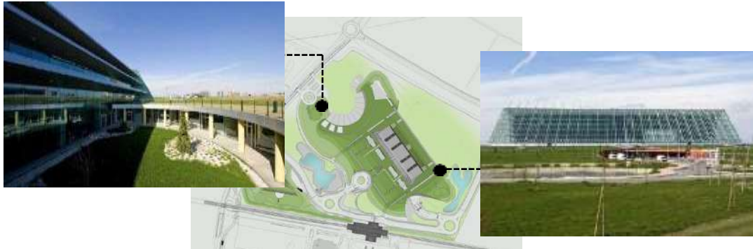
Figura n.º 4.14. Jardines Exteriores que rodean el edificio
