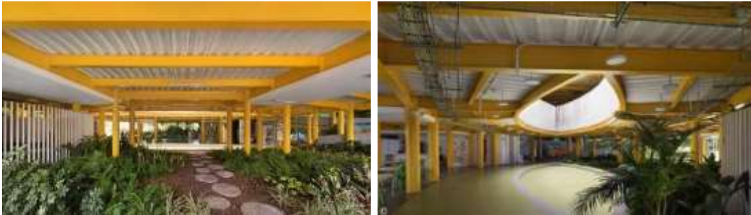
Figura n.º 4.25. Presencia de jardines interiores cerca de corredores
