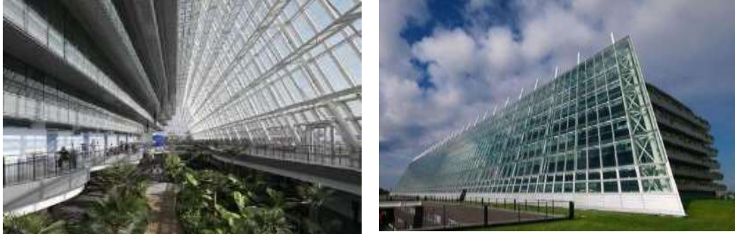
Figura n.º 4.23. Presencia de muros cortina en salas de espera
