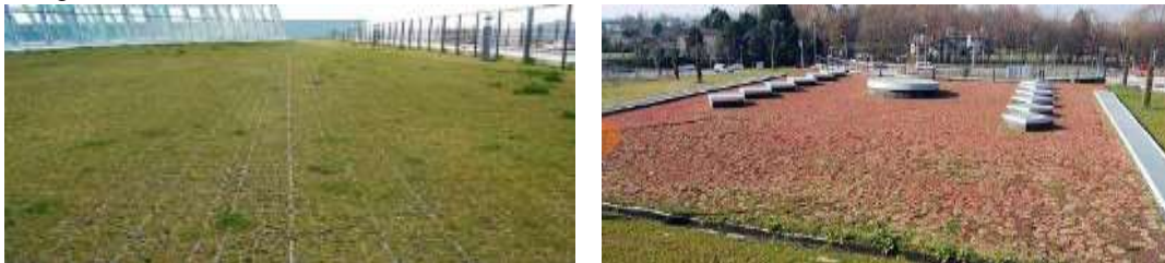
Figura n.º 4.20. Presencia de cubierta verde transitable como elemento de interacción
