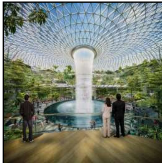
Figura N° 08 Cascada central como Sistema de Enfriamiento Pasivo.
