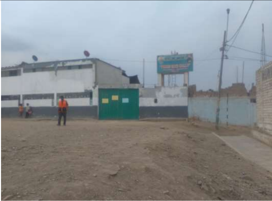
Foto N°5: Vista de la I.E. N° 3074 “Pedro Ruiz Gallo”
