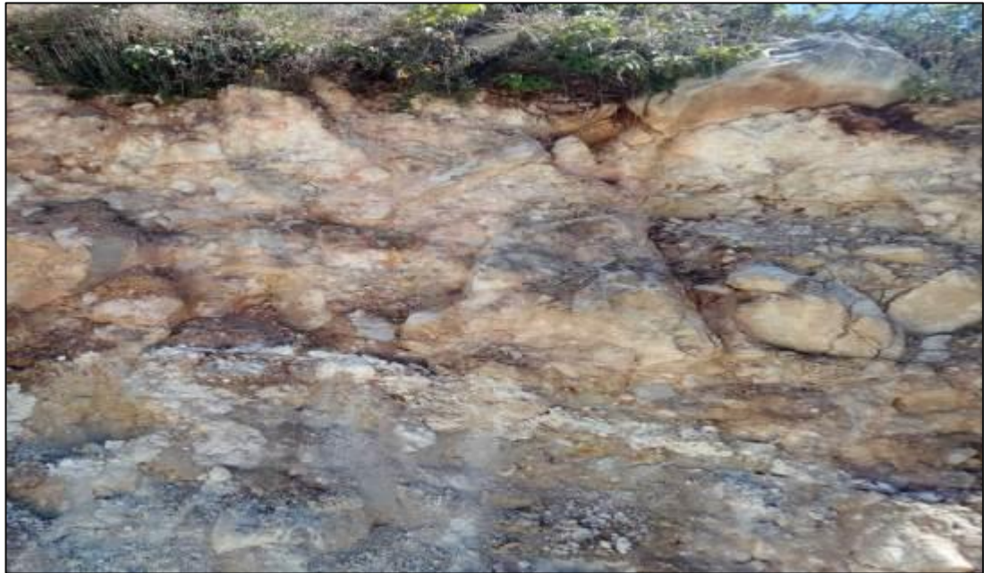
Figura 5. Depósito cuaternario con un espesor aproximado de 2 m. del tipo coluvio-deluvial
