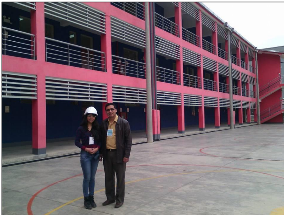
Figura 64. Comprobación de la toma de datos del edificio en estudio por parte del Ing. Miguel Mosqueira
