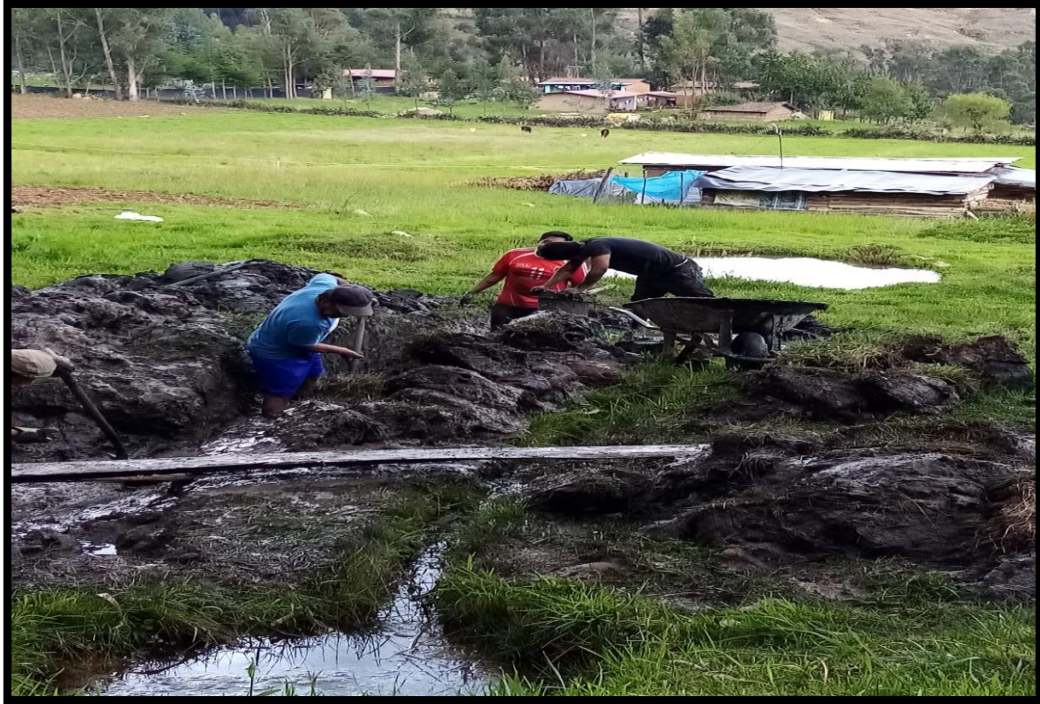
Figura 18: Excavación manual de la galería filtrante.
