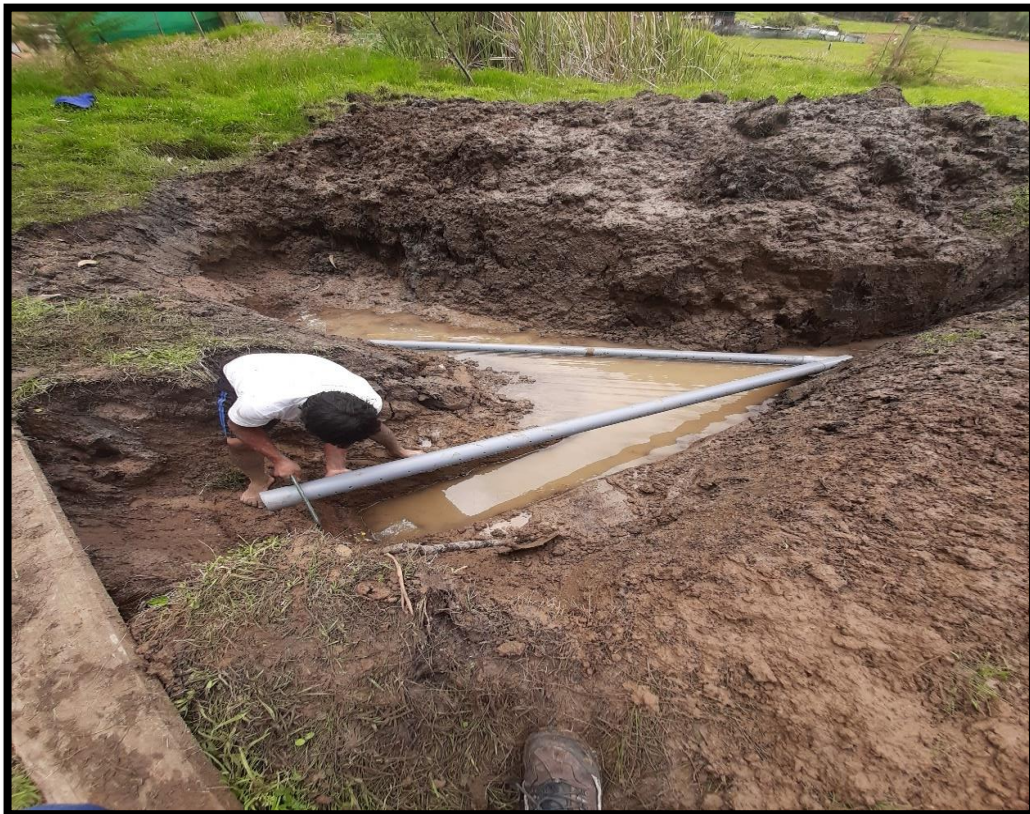
Figura 21: Colocación de la tubería.
