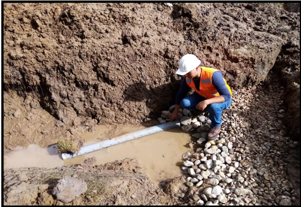
Figura 22: Colocación de over 3” a 4”.
