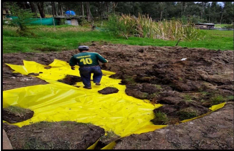
Figura 13: Relleno con material propio.
