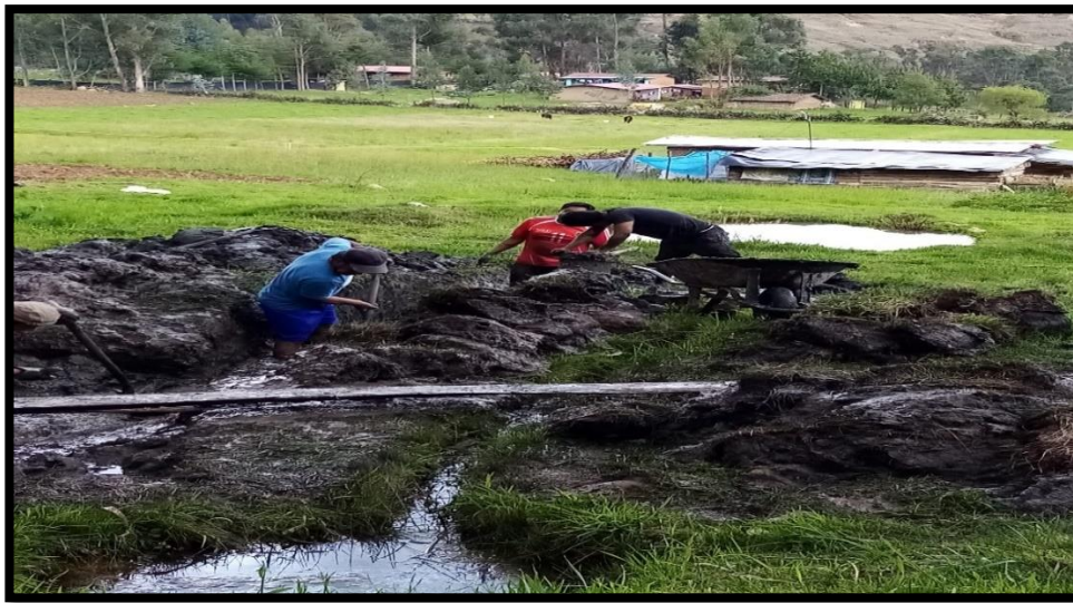
Figura 7: Excavación manual de la galería filtrante.
