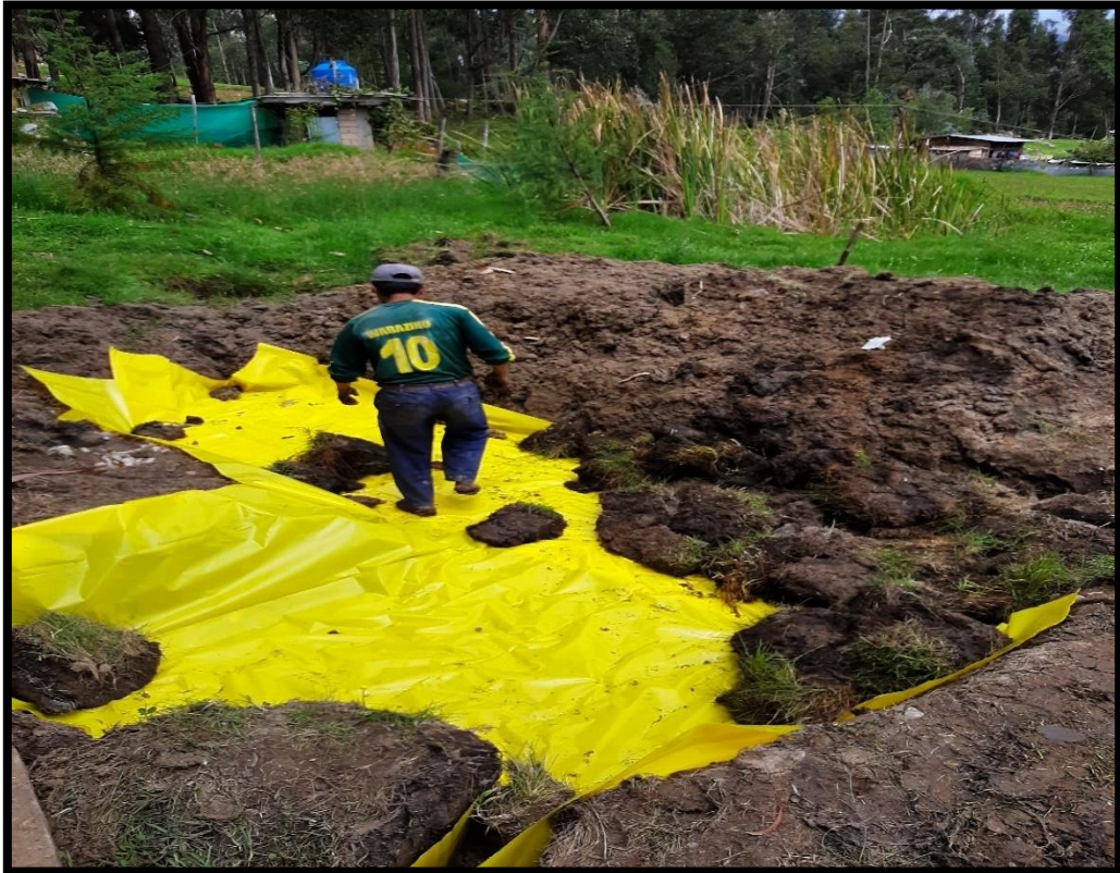
Figura 24: Relleno con material propio.
