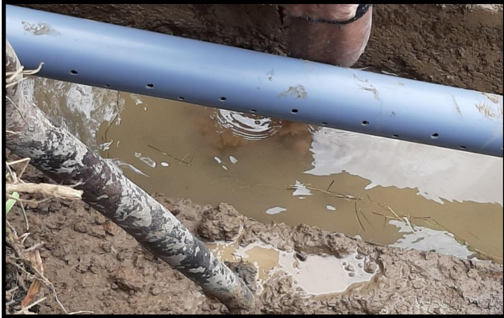
Figura 9: Perforación de la tubería.
