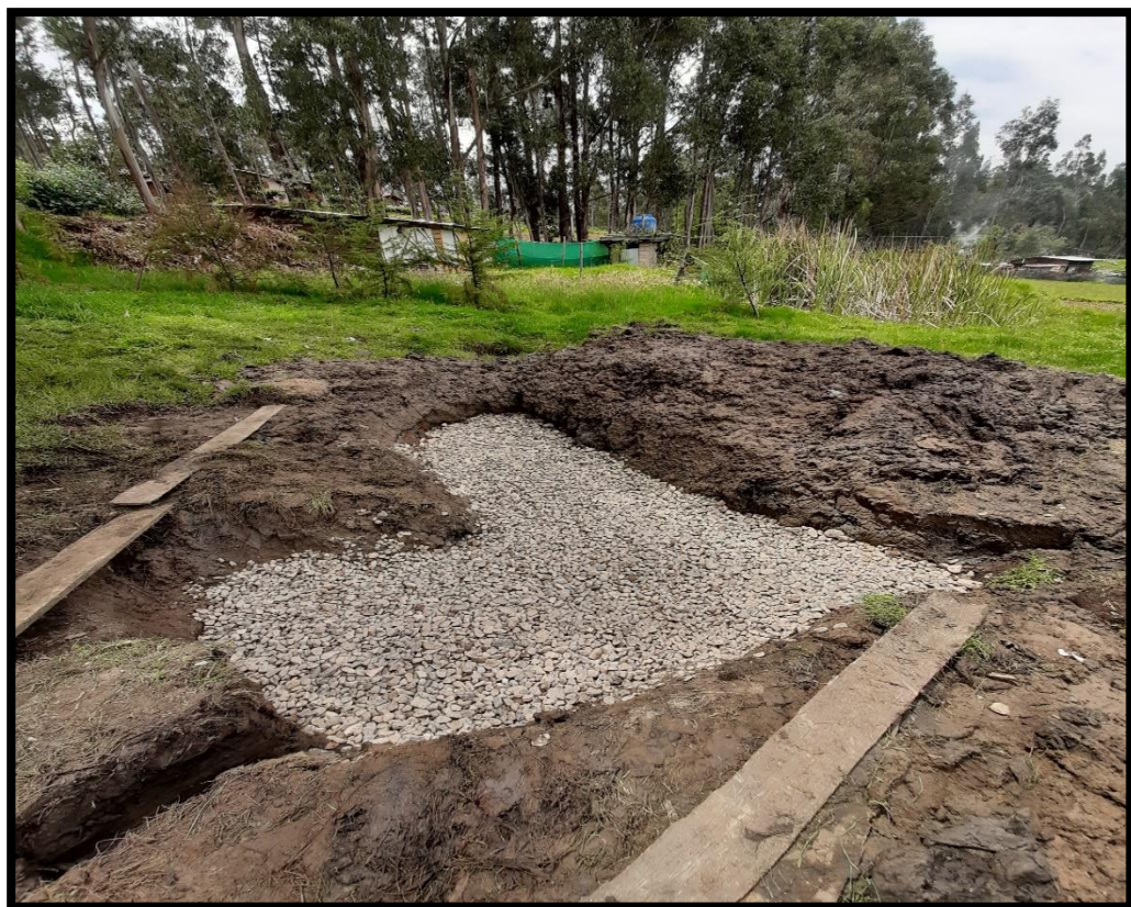
Figura 23: Colocación de piedra de rio 1” a 2”.
