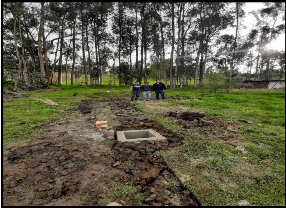
Figura 15: Finalización del proceso constructivo.
