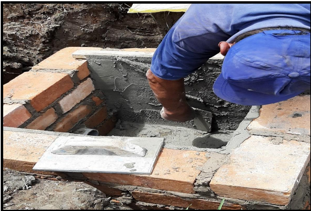
Figura 25: Construcción de caja de registro.
