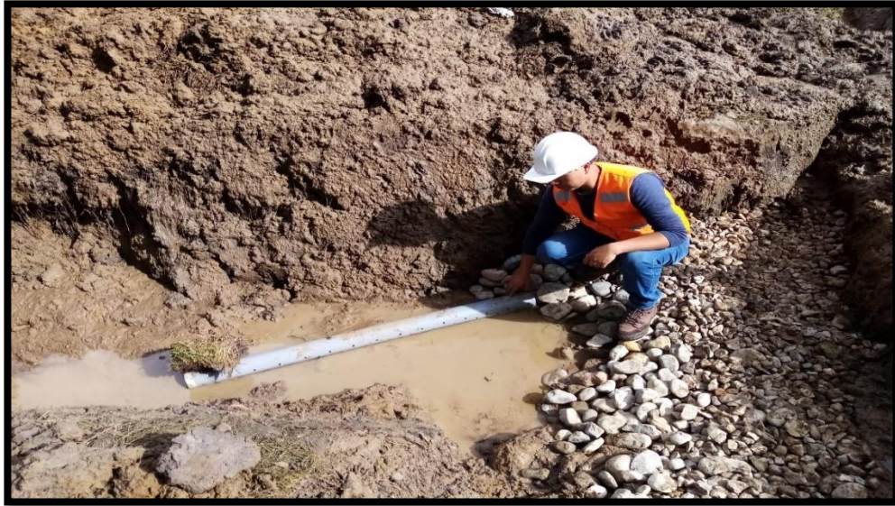
Figura 11: Colocación de over 3" a 4"
