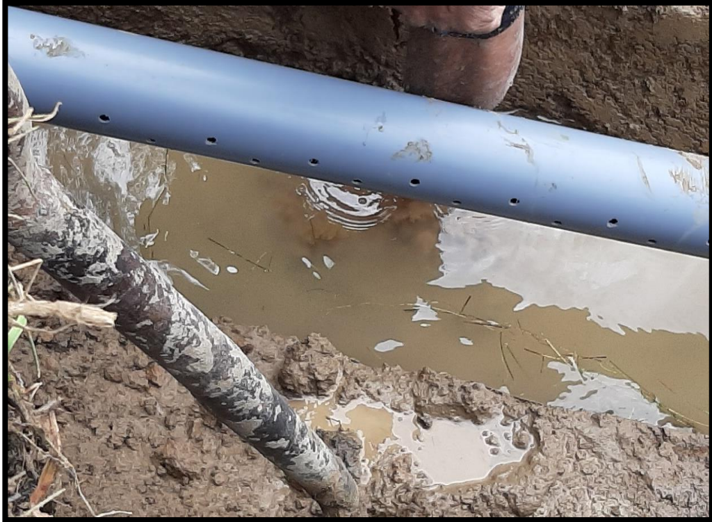
Figura 20: Perforación de la tubería.
