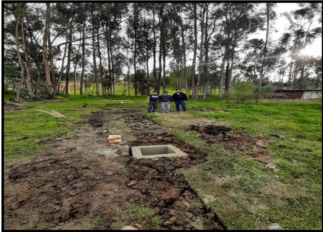
Figura 26: Finalización de la construcción.
