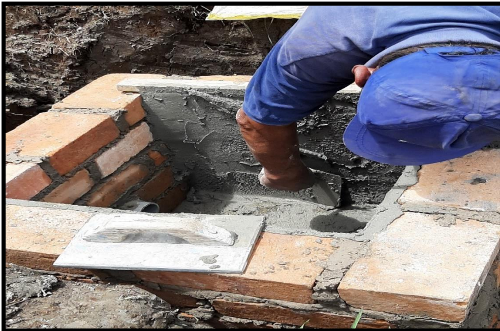
Figura 14: Caja de registro.
