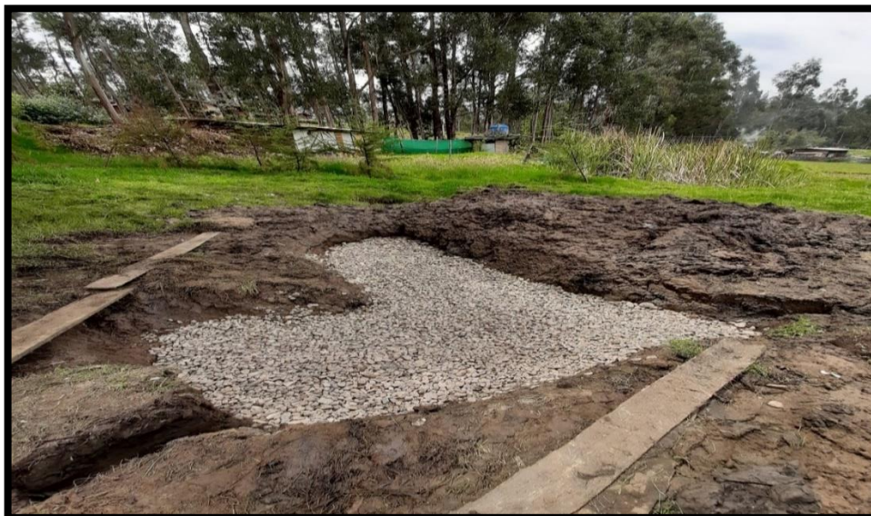
Figura 12: Colocación de piedra de río 1" a 2"
