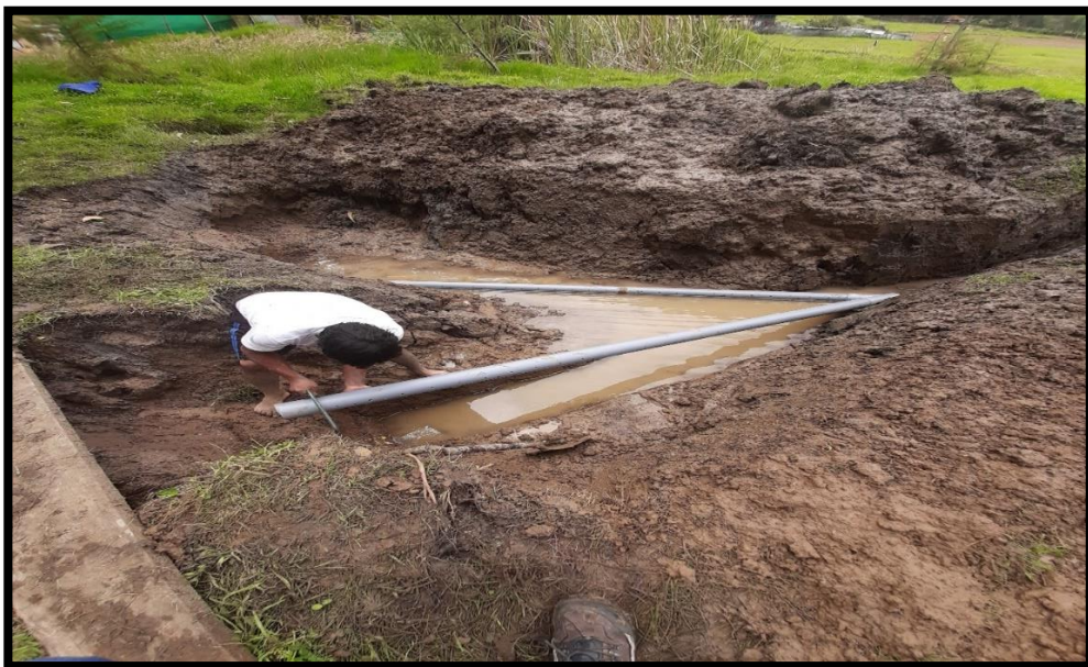
Figura 10: Colocación de la tubería.
