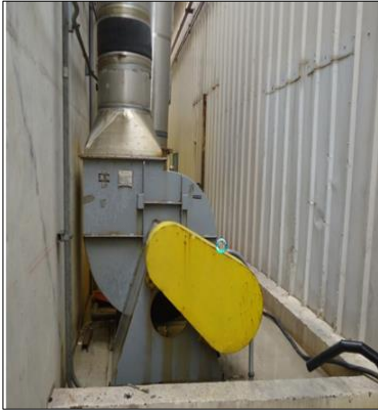
Figura 39 ventilador centrifugo.
