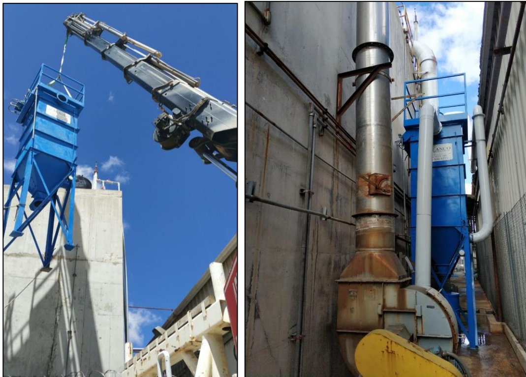
Figura 38 Instalación del colector de polvos.
