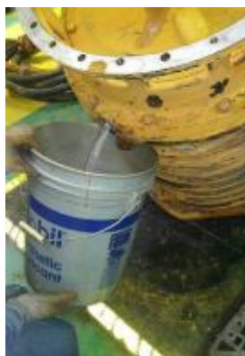
Figura 14. Se encuentra agua en la cámara de aceite
