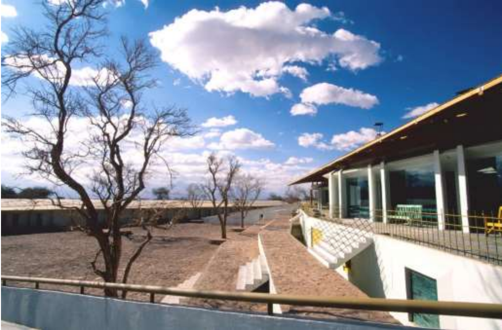
Figura 17, Aplicación de plataformas
