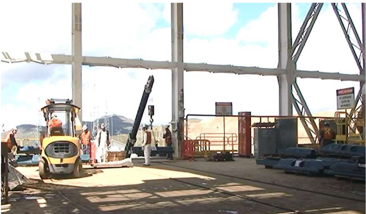
Foto 2. Traslado de liners utilizando Grúa de 25 tn, Montacargas.
