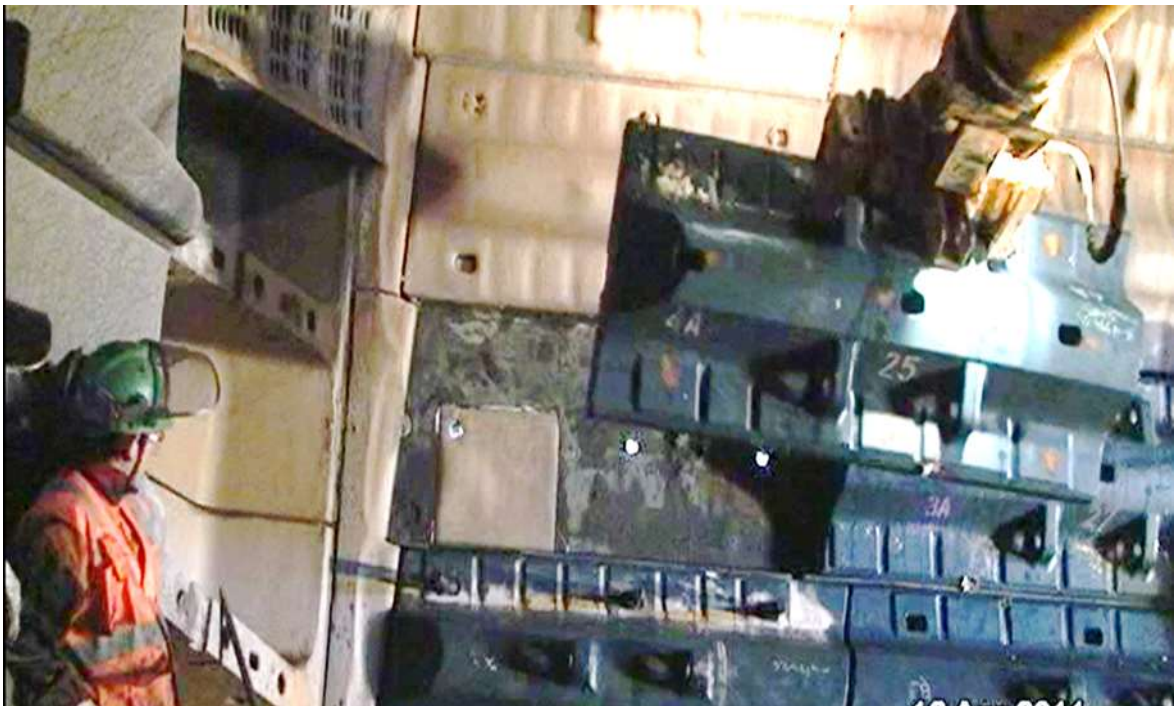
Foto 4. Instalación de liners Shell, utilizando Máquina enlainadora de Capacidad 4500 kg.
