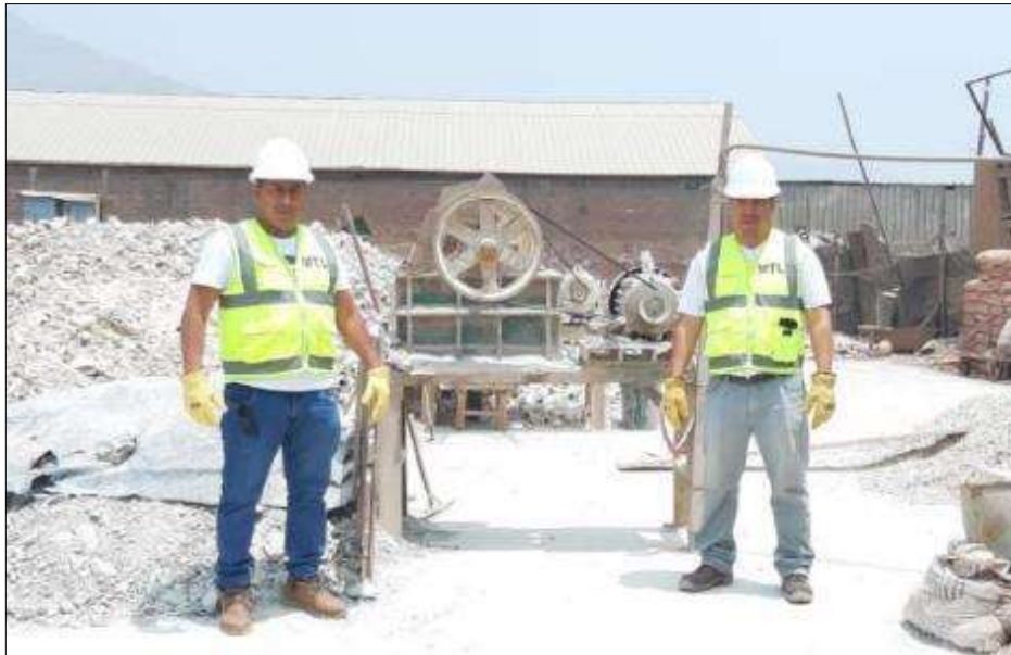
Figura 13: Trituración de concreto reciclado en máquina (trituradora mandíbula)
