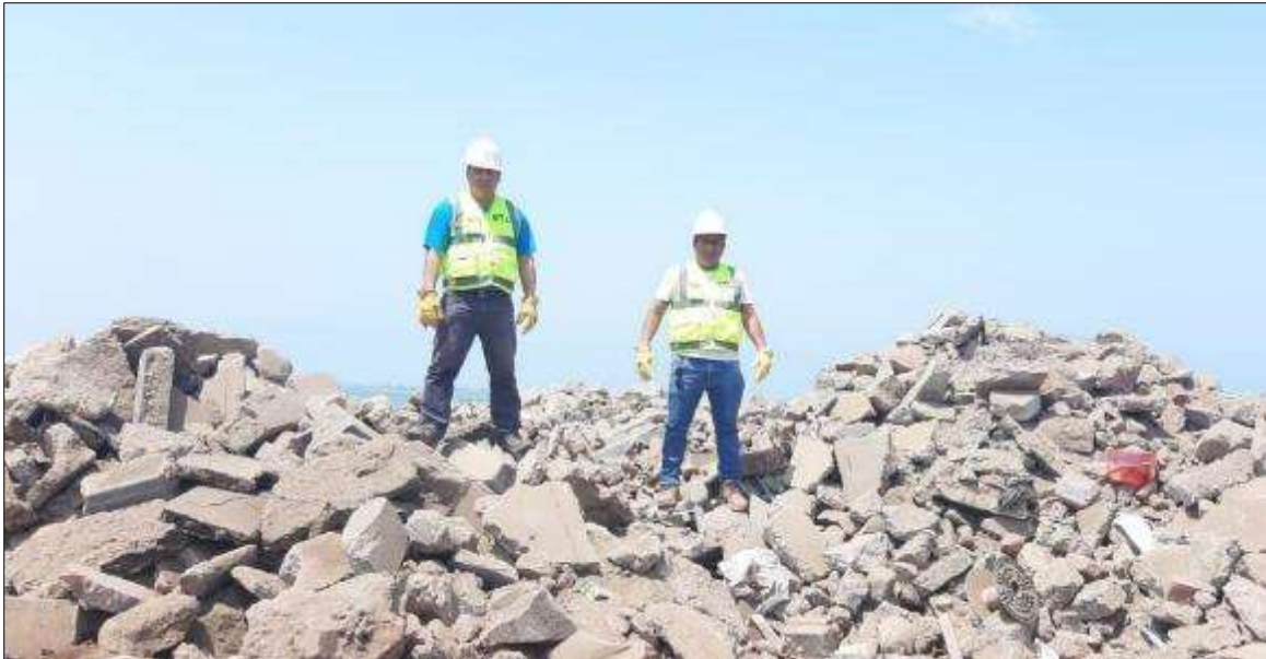
Figura 11: Recolección de concreto reciclado en vertedero informal en las riveras del litoral de Oquendo – Callao
