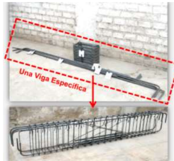
Figura 31: Viga empaquetada y después Armada
