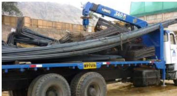
Figura 14: Fotografía de la llegada del camión a obra con el ACEDIM
