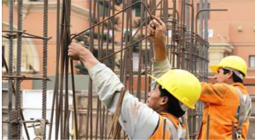
Figura 58: Instalación del ACEDIM
