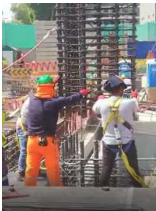
Figura 57: Instalación del Acero pre armado
