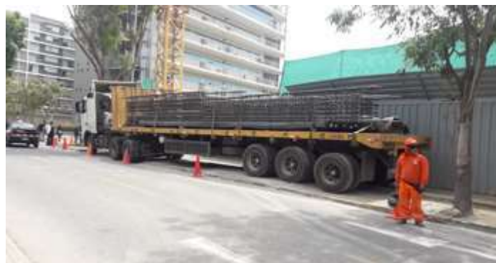
Figura 55: Entrega en Obra de pre armado
