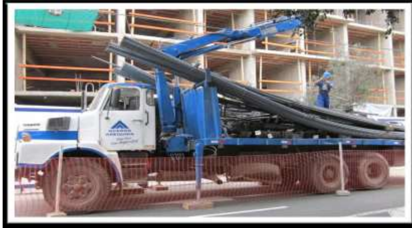
Figura 35: Llegada de acero a obra
