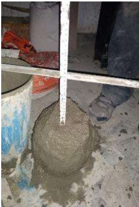
Slump del concreto
