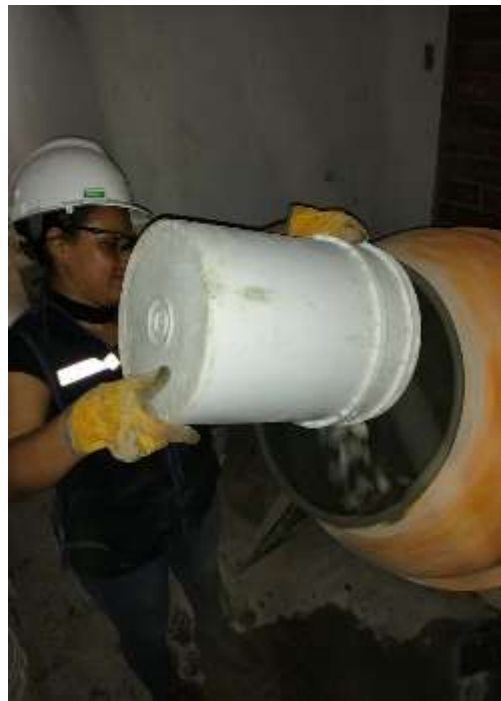
Adicionando los agregados
