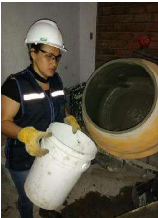
Iniciando la preparación de mezcla
