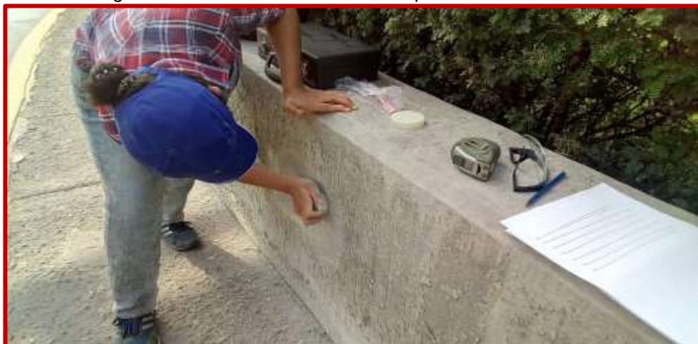
Imagen 18. Prueba del esclerómetro limpieza del muro a analizar
