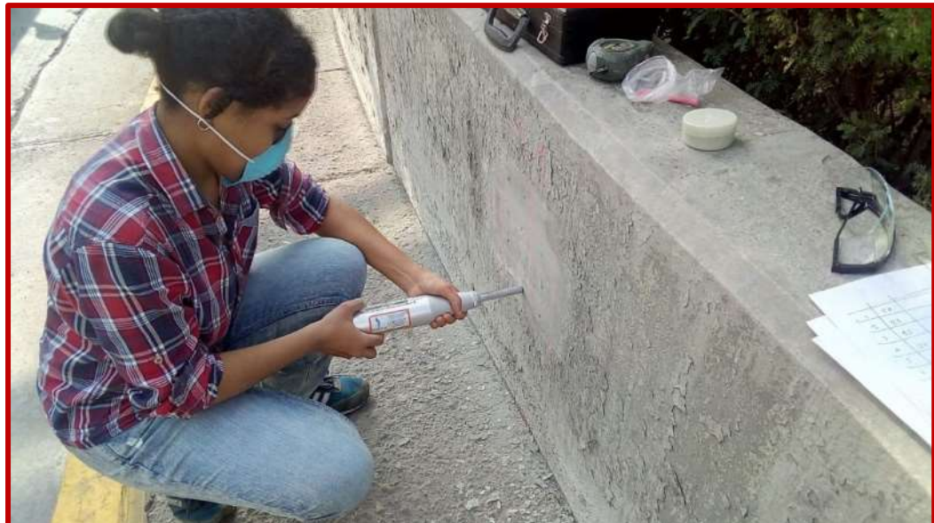
Imagen 20. Prueba del esclerómetro en los muros estructurales
