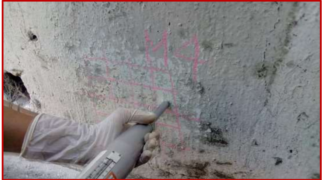
Imagen 19. Prueba del esclerómetro en los muros estructurales
