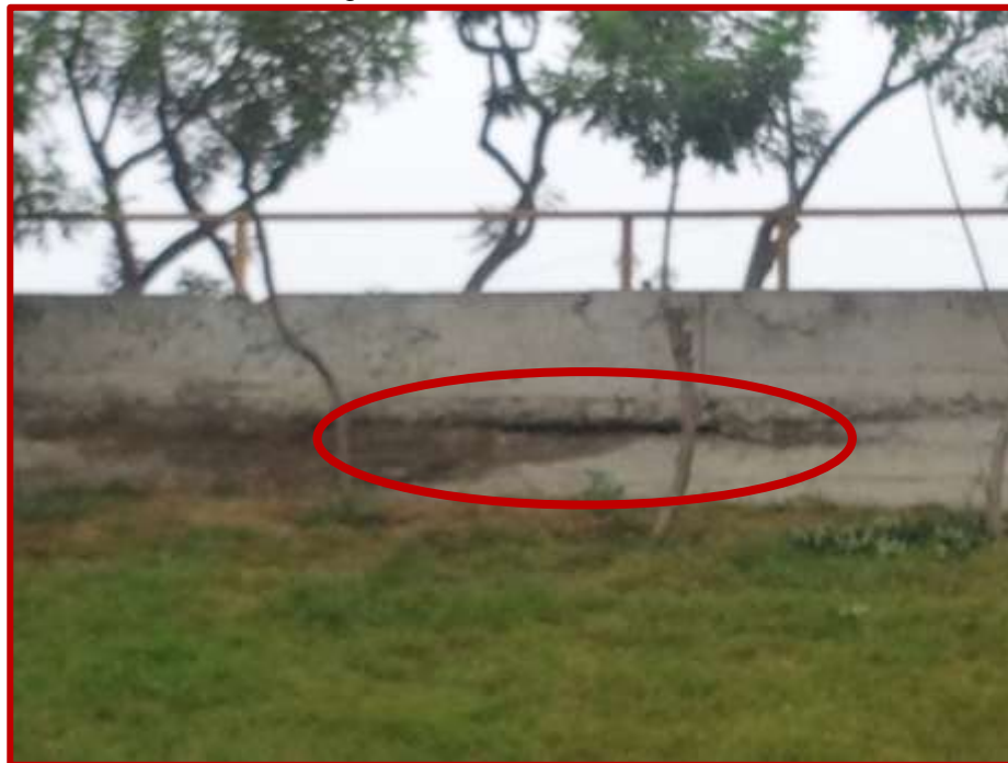
Figura 1. Muro estructural de concreto
