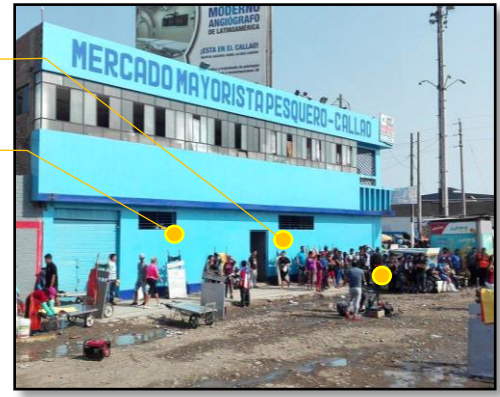
D. INVASIÓN EN VEREDAS Y VENTA EN EL PISO
