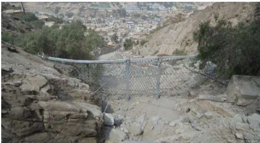
Figura 14: Estado de la barrera dinámica 02 ubicada en la Quebrada Carossio Fuente: Elaboración Propia
