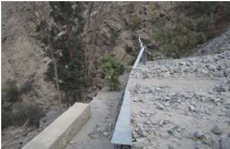
Figura 16: Estado de la barrera dinámica 03 ubicada en la Quebrada Carossio Fuente: Elaboración Propia
