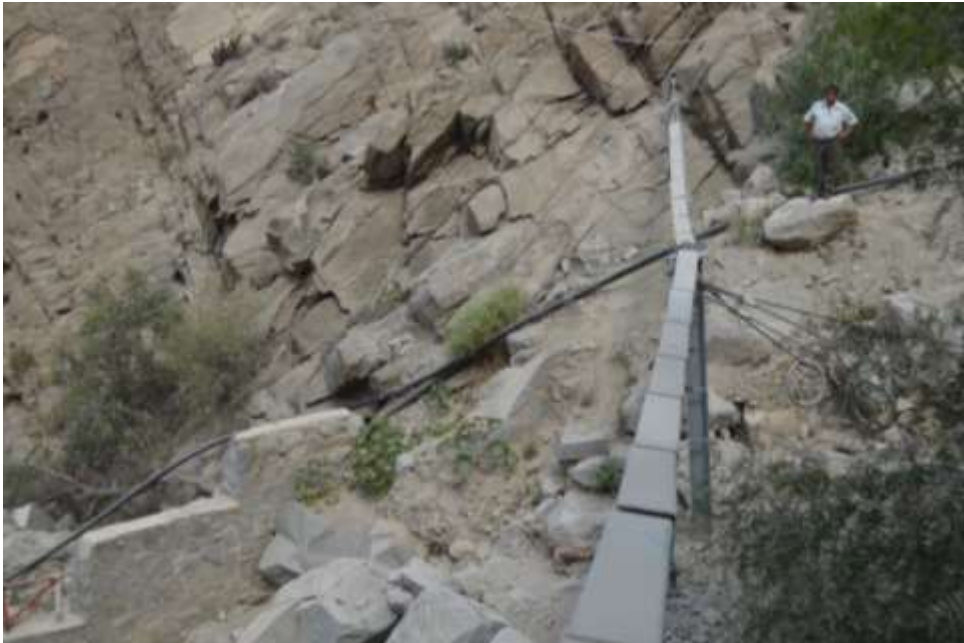
Figura 12: Estado de la barrera dinámica 01: ubicada en la Quebrada Carossio Fuente: Elaboración Propia
