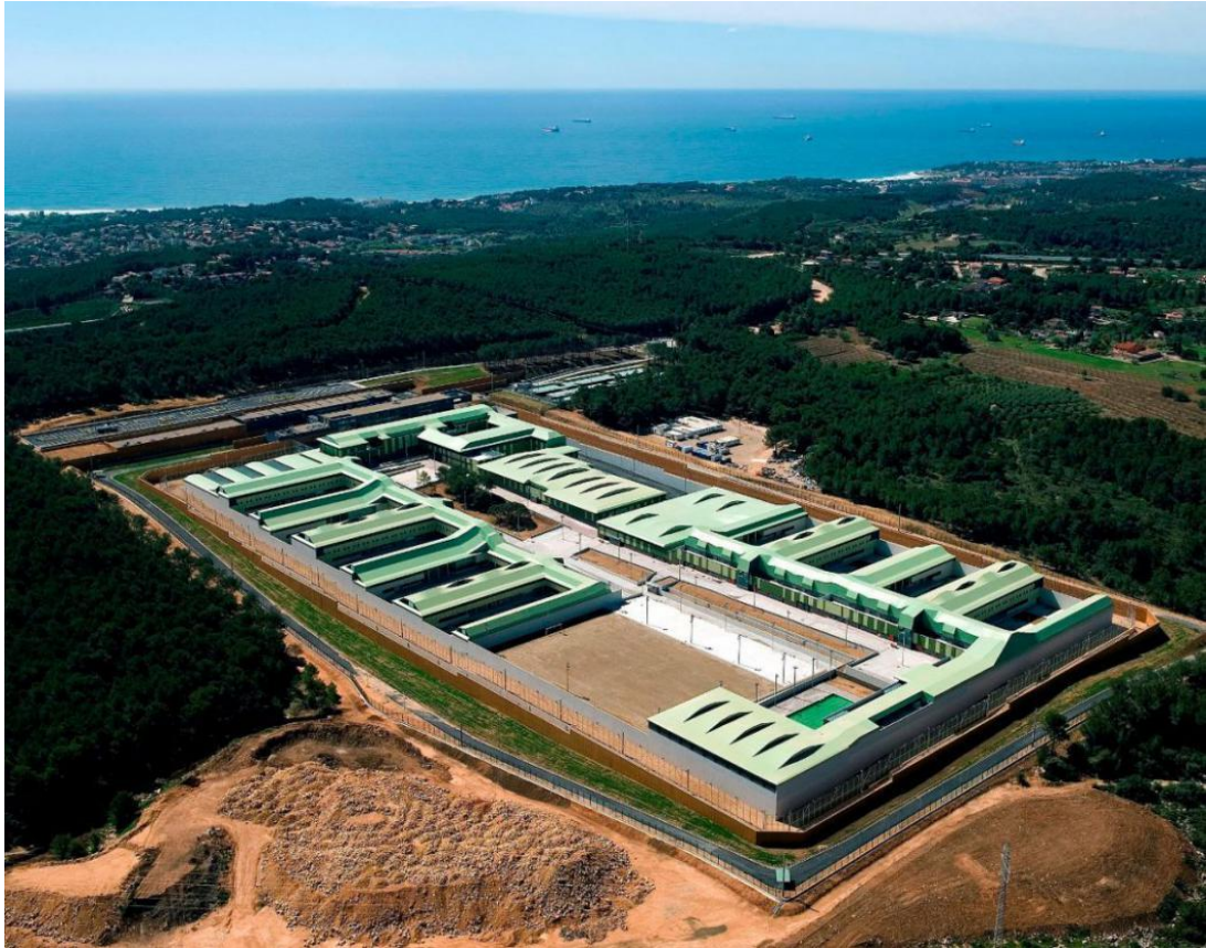
Figura 6: Vista aérea de Centro Penitenciario Mas d'Enric
