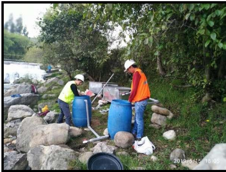
FIGURA 53 instalación de filtros
