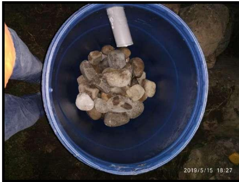
FIGURA 61 Canto rodado de 3/4 Capa 01 de filtro de carbón activo
