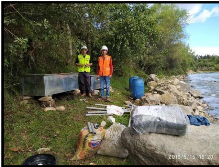
FIGURA 52 Materiales y proceso de instalación
