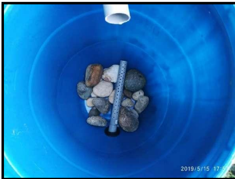
FIGURA 54 Capa 01 de filtro con arcilla y piedra caliza
