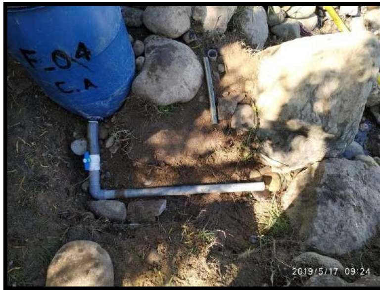
FIGURA 67 Punto de control Filtro 04
