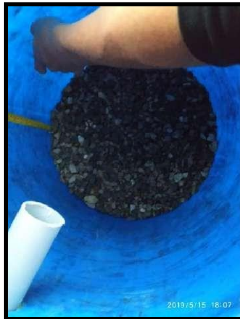
FIGURA 55 Capa 02 de filtro con arcilla y piedra caliza
