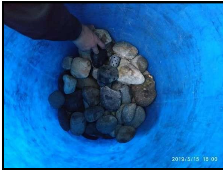
FIGURA 55 Capa 02 de filtro con arcilla y piedra caliza
