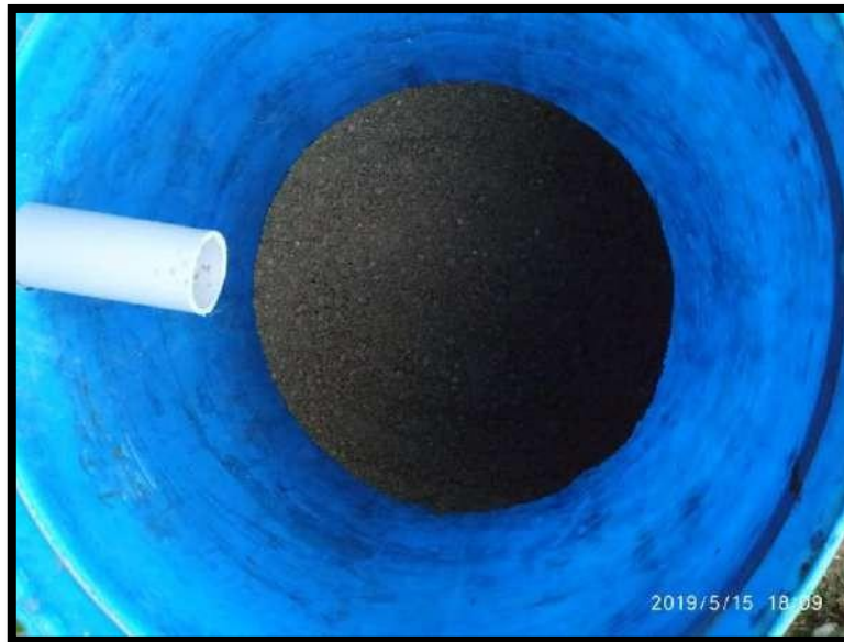
FIGURA 57 Arena gruesa capa 04 de filtro con arcilla y piedra caliza
