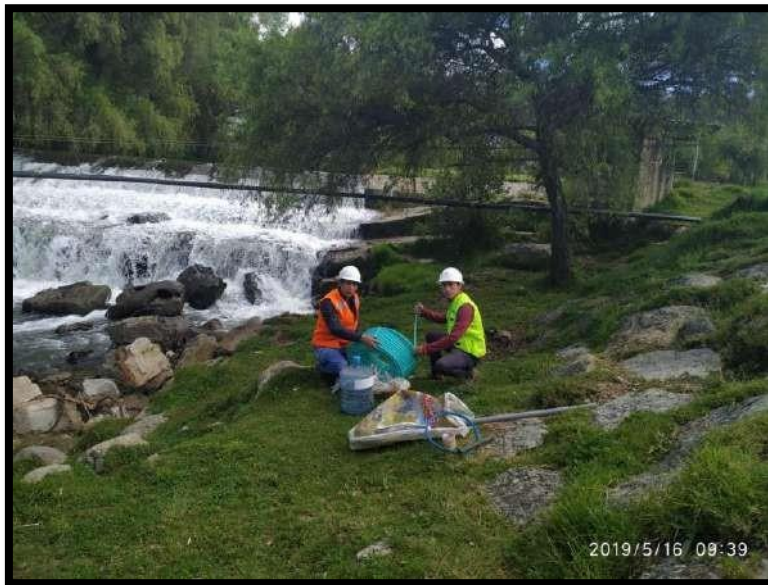
FIGURA 50 Proceso de instalación en campo
