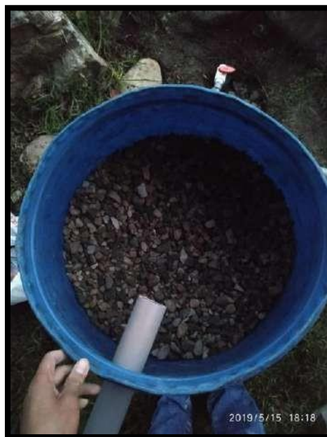
FIGURA 60 Gravilla capa 07 de filtro con arcilla y piedra caliza
