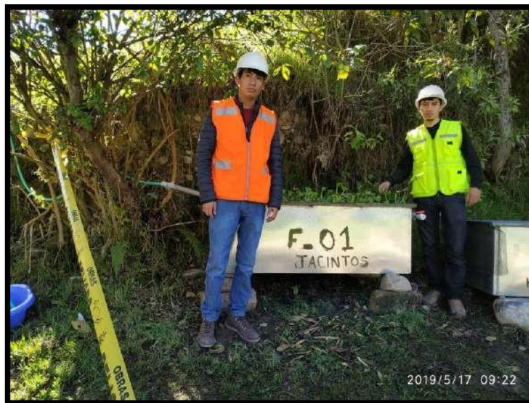
FIGURA 68 filtro 01 macrofitas flotantes (jacintos de agua)
