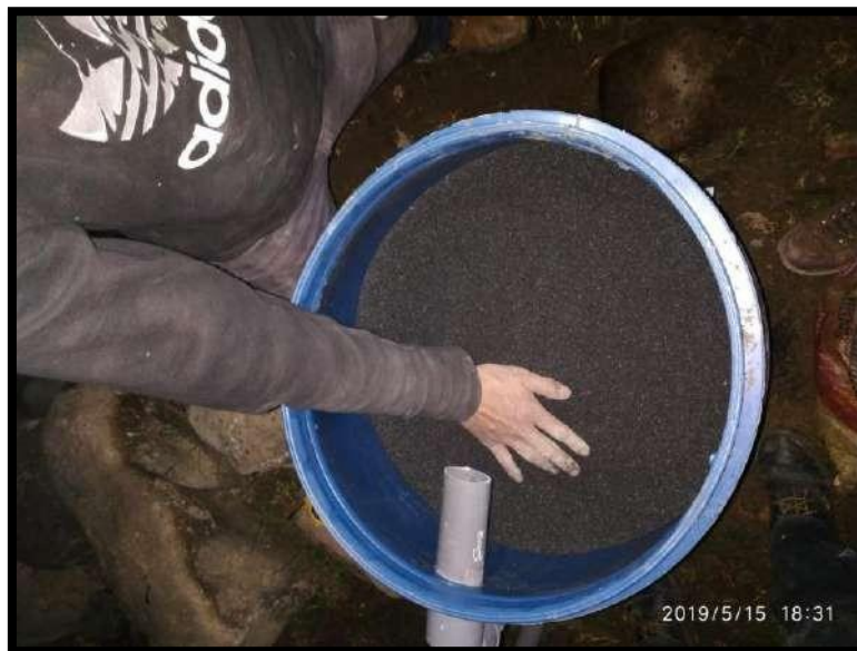
FIGURA 64 Carbón capa 04 de filtro de carbón activado
