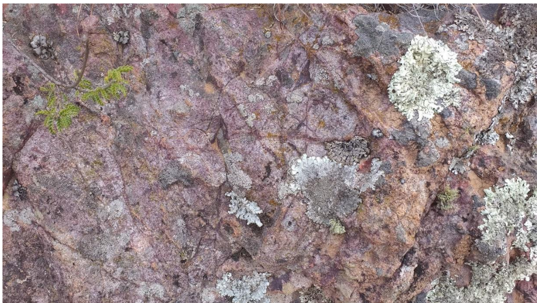
Figura 22: Areniscas de la formación Farrat con presencia de enjambre de vetillas (stockwork).
