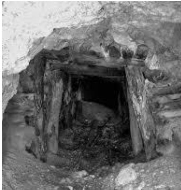
Figura 7: imagen de la condición del sostenimiento de la bocamina BY-04. Foto propia (2019).
