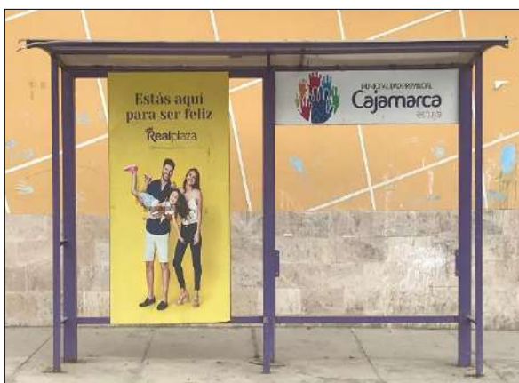
Foto N° 5. Paradero Los Nogales
