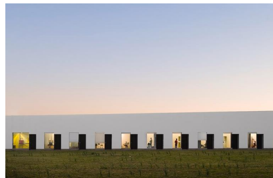
Figura 20 Vista desde el patio interior
