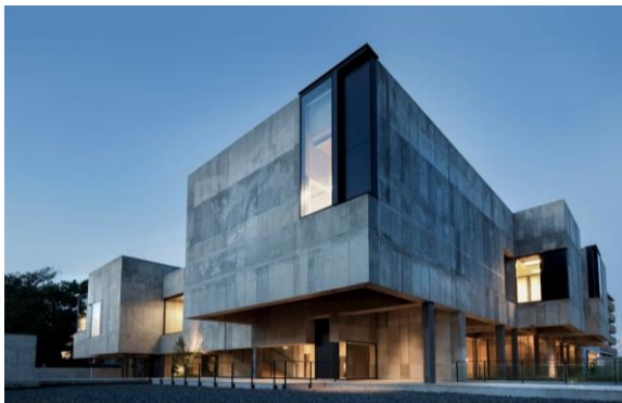
Figura 1 Vista del exterior del edificio
