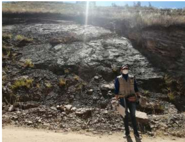
Figura 25. Talud de roca de la Estación de Control Geomecánico N°02
