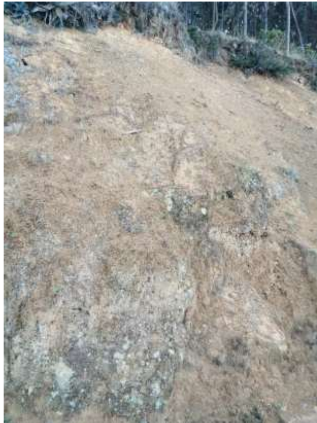
Figura 28. Talud de Suelo analizado por criterio Mohr - Coulomb
