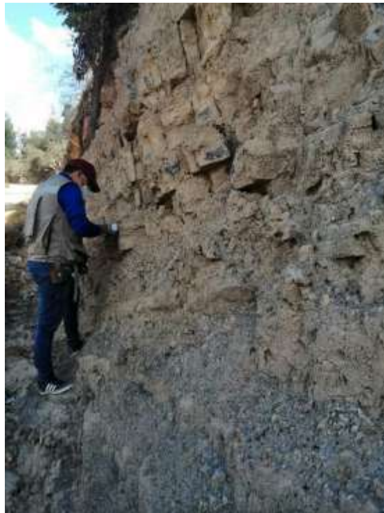
Figura 27. Talud de roca de la Estación de Control.
