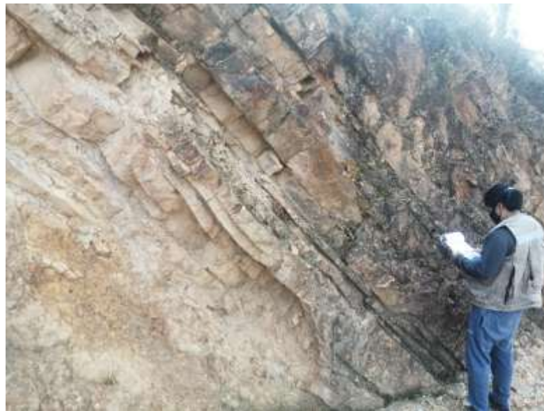
Figura 23. Talud de roca de la Estación de Control Geomecánico N°01
