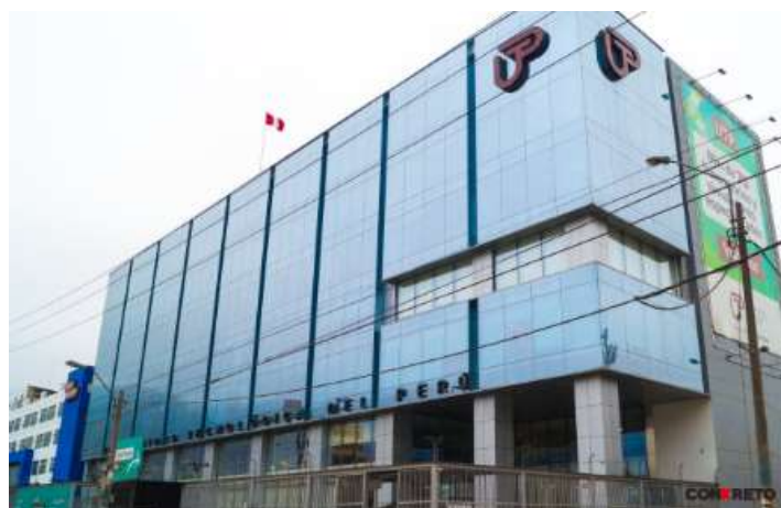
Figura 18. Proyecto UTP San Juan de Lurigancho. Fuente: Conkreto Ingeniería y Construcción S.A.C
