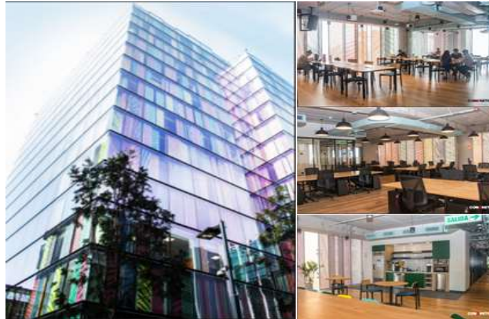
Figura 22. Proyecto Oficinas Wework Real 2. Fuente: Concreto Ingeniería y Construcción S.A.C
