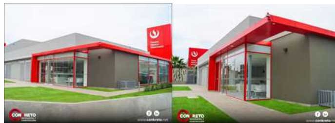
Figura 31. Proyecto Clínica Veterinaria UPC – Chorrillos. Fuente: Conkreto Ingeniería y Construcción S.A.C
