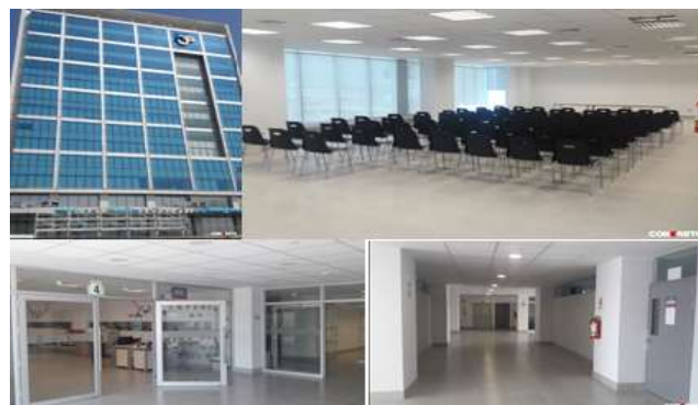
Figura 17. Proyecto UTP Norte. Fuente: Conkreto Ingeniería y Construcción S.A.C
