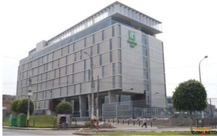
Figura 8. Proyecto Hotel Aeropuerto Holiday Inn. Fuente: Conkreto Ingeniería y Construcción S.A.C
