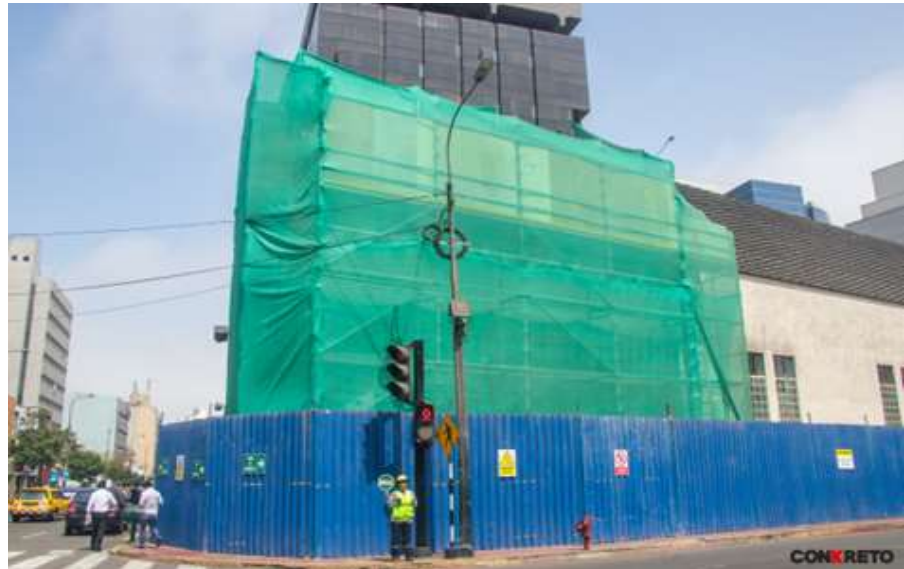
Figura 6. Proyecto Centro Comercial Camino Real. Fuente: Conkreto Ingeniera y Construcción S.A.C.
