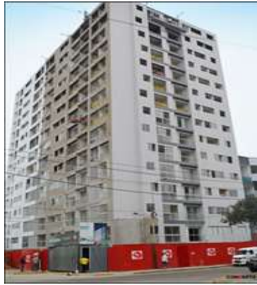
Figura 30. Proyecto Edificio Las Palmas – Magdalena. Fuente: Conkreto Ingeniería y Construcción S.A.C
