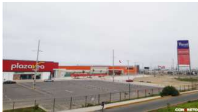
Figura 10. Proyecto Real Plaza Nuevo Chimbote. Fuente: Conkreto Ingeniería y Construcción S.A.C
