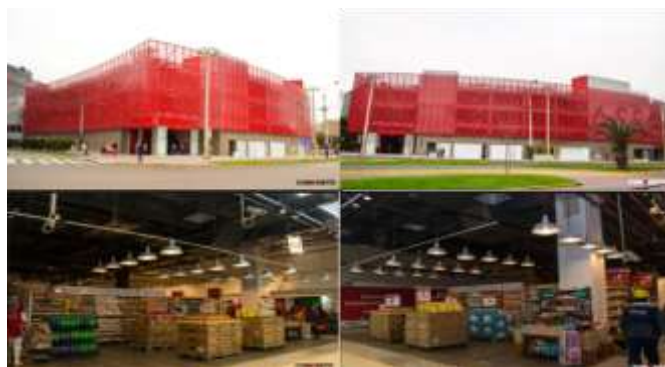
Figura 15. Proyecto Plaza Vea Dasso. Fuente: Conkreto Ingeniería y Construcción S.A.C
