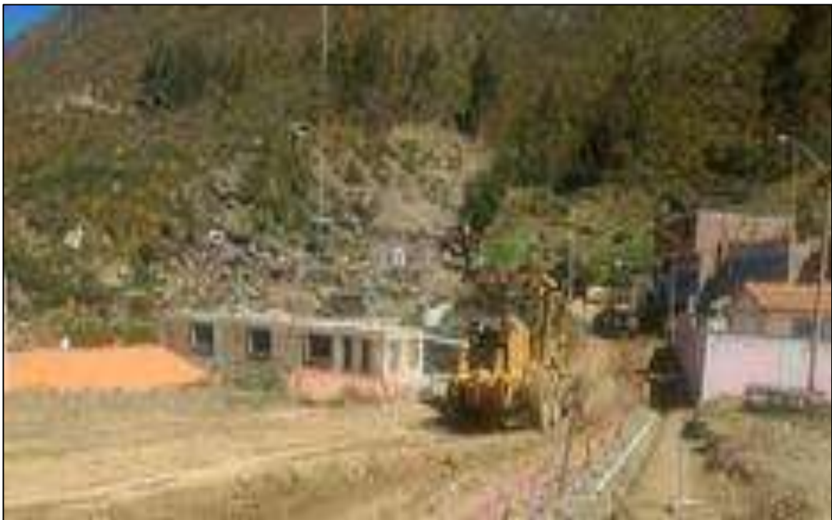
Figura 61. Movimiento de Tierra
