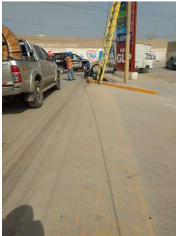
Figura N° 52 Instalación de la fibra óptica
