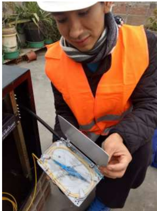
Figura N° 56 Instalación a cliente
