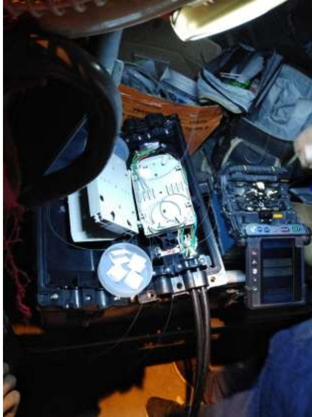
Figura N° 53 Fusión de la fibra óptica
