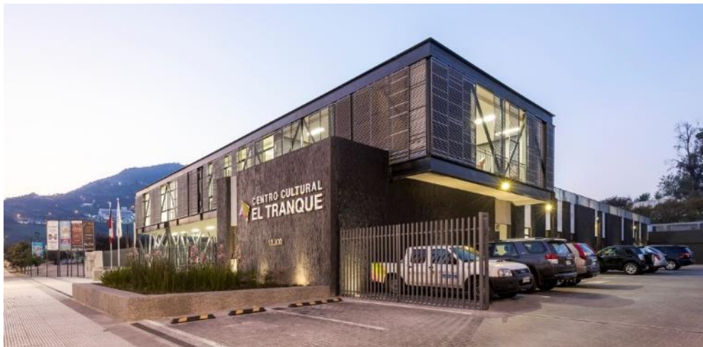
Ilustración 27: Vista fachada frontal C. C. El Tranque
