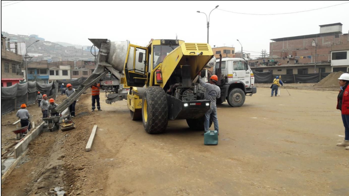
Figura N° 3. Vaciado de concreto utilizando mezcladora en el proyecto A. Autoría propia.
