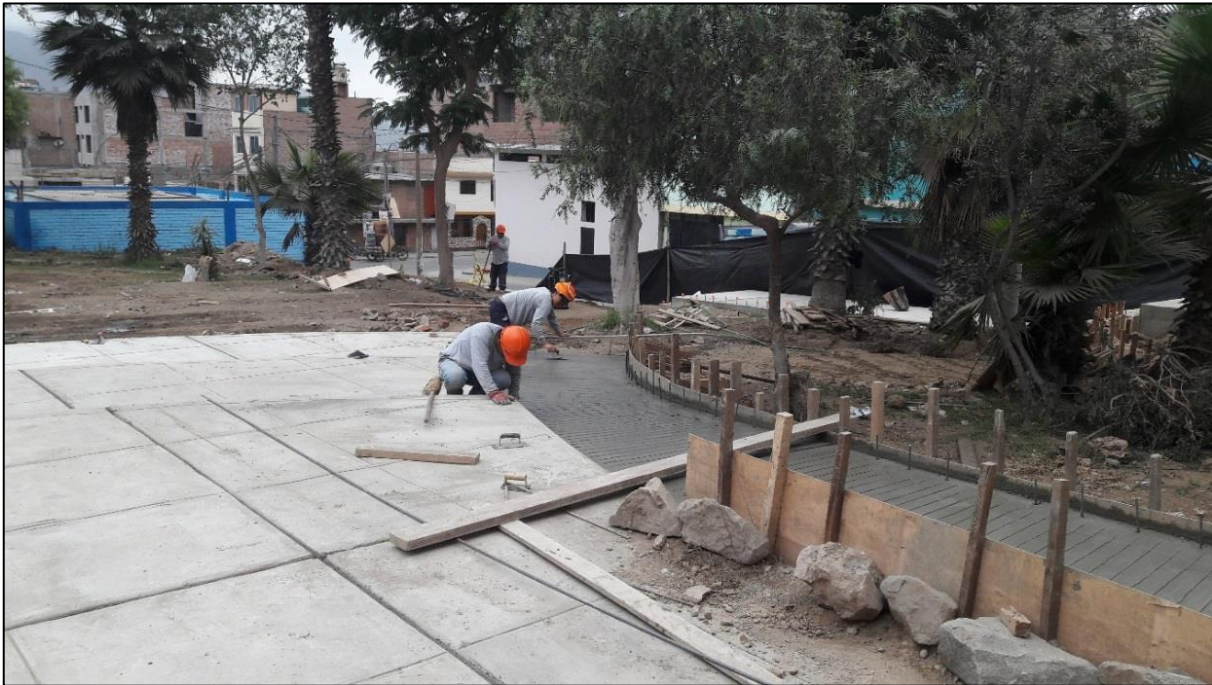
Figura N° 11. Pulido y dibujado de gruñas en la rampa de concreto e implementación de la gestión de proyectos del proyecto B. Autoría propia.
