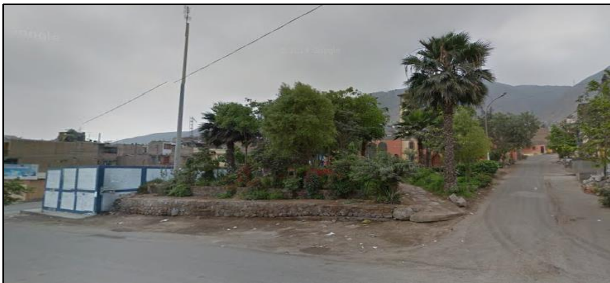
Figura N° 40. La imagen evidencia la falla de áreas de circulación y recreación. Autoría propia.
