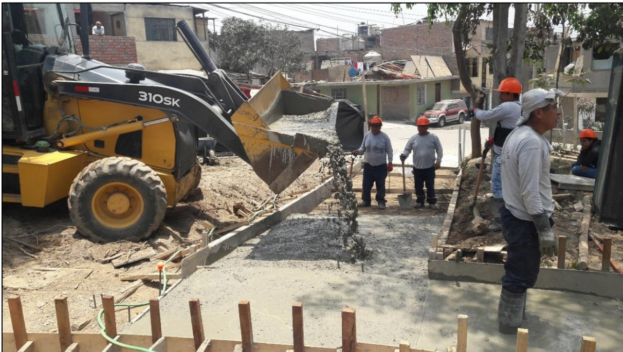
Figura N° 12. Vaciado de concreto para la rampa e implementación de la gestión de proyectos del proyecto B. Autoría propia.
