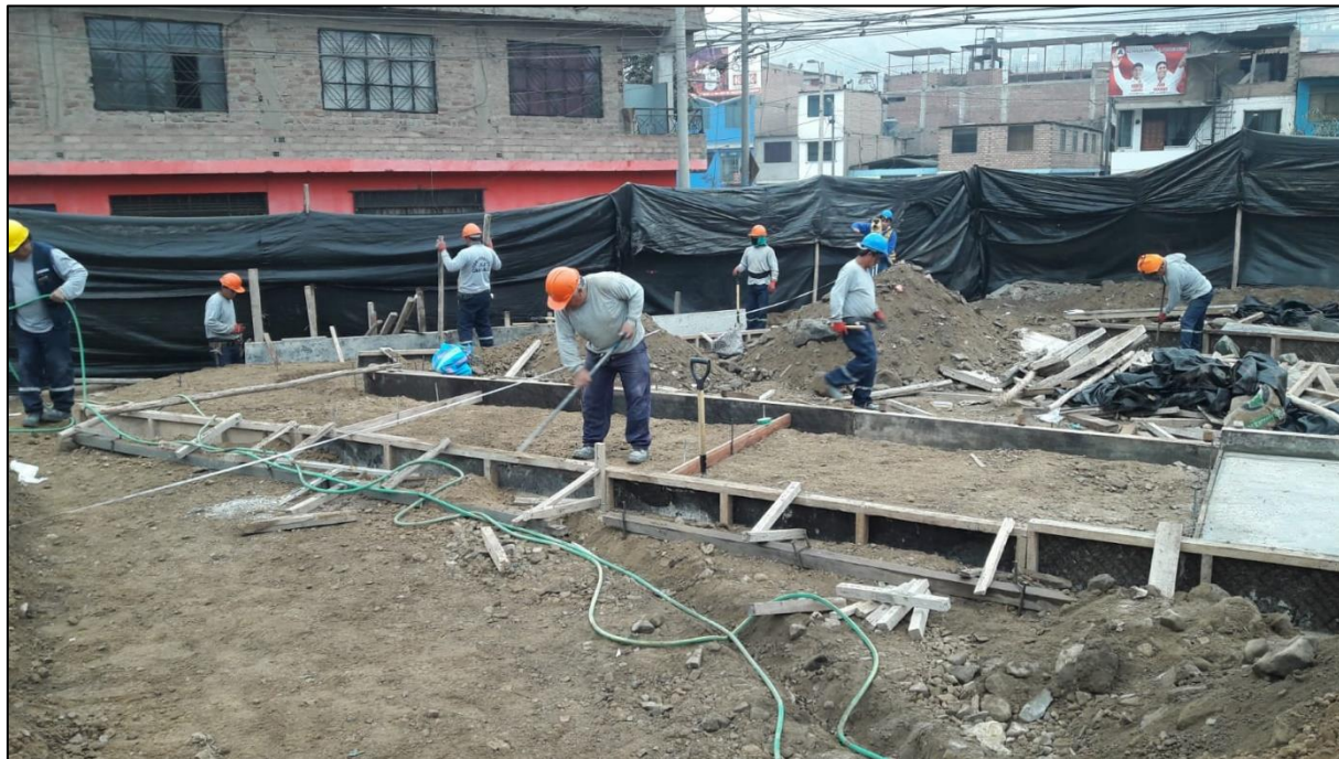
Figura N° 4. Colocación del encofrado para vereda en el proyecto A. Autoría propia.
