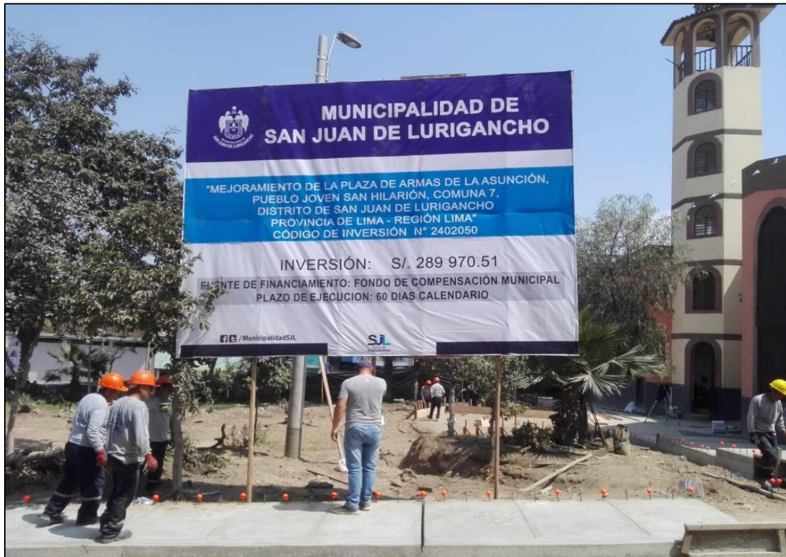
Figura N ° 7. Colocación del cartel de obra e implementación de la gestión de proyectos del proyecto B. Autoría propia.
