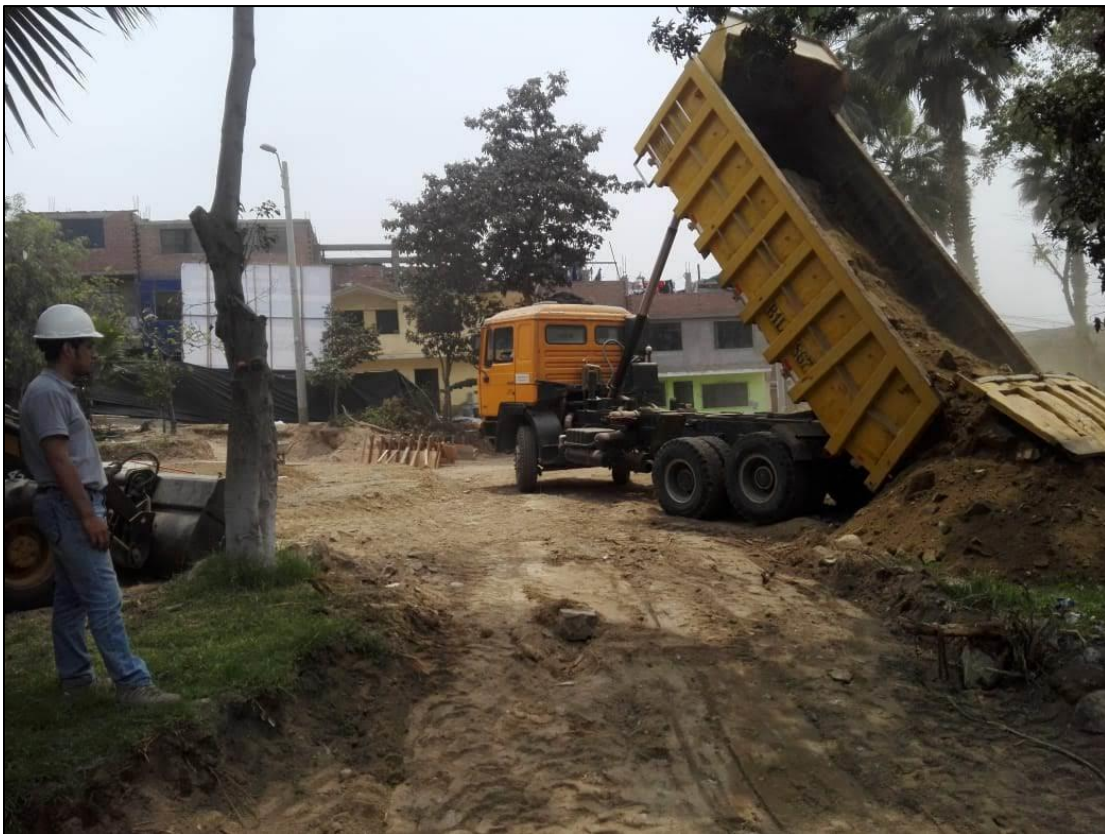
Figura N ° 14. Vaciado de afirmado e implementación de la gestión de proyectos del proyecto B. Autoría propia.
