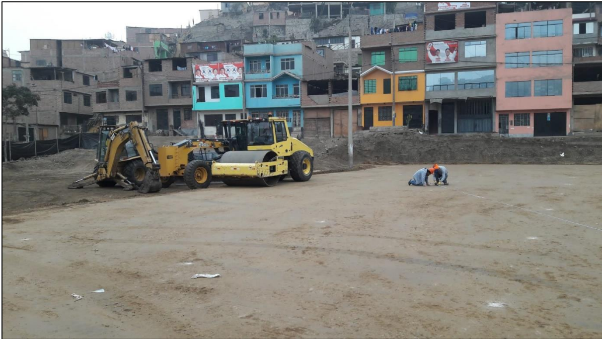
Figura N ° 5. Compactación y trazos topográficos para la construcción de vereda del proyecto A. Autoría propia.
