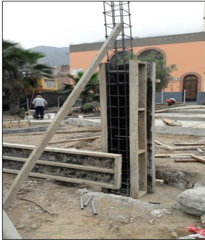
Figura N ° 15. Encofrado de columna e implementación de la gestión de proyectos del proyecto B. Autoría propia.
