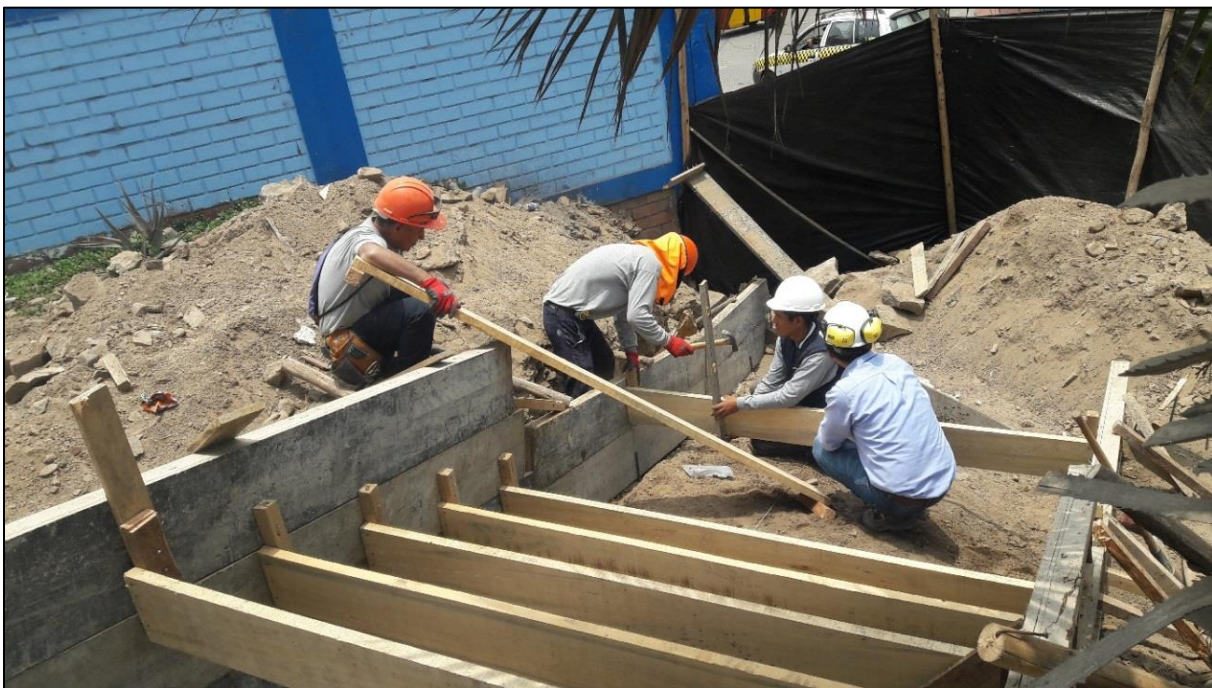
Figura N ° 8. Encofrado de escaleras e implementación de la gestión de proyectos del proyecto B. Autoría propia.
