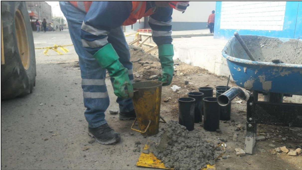
Figura N ° 13. Prueba de Slump del concreto de vereda del proyecto B. Autoría propia.
