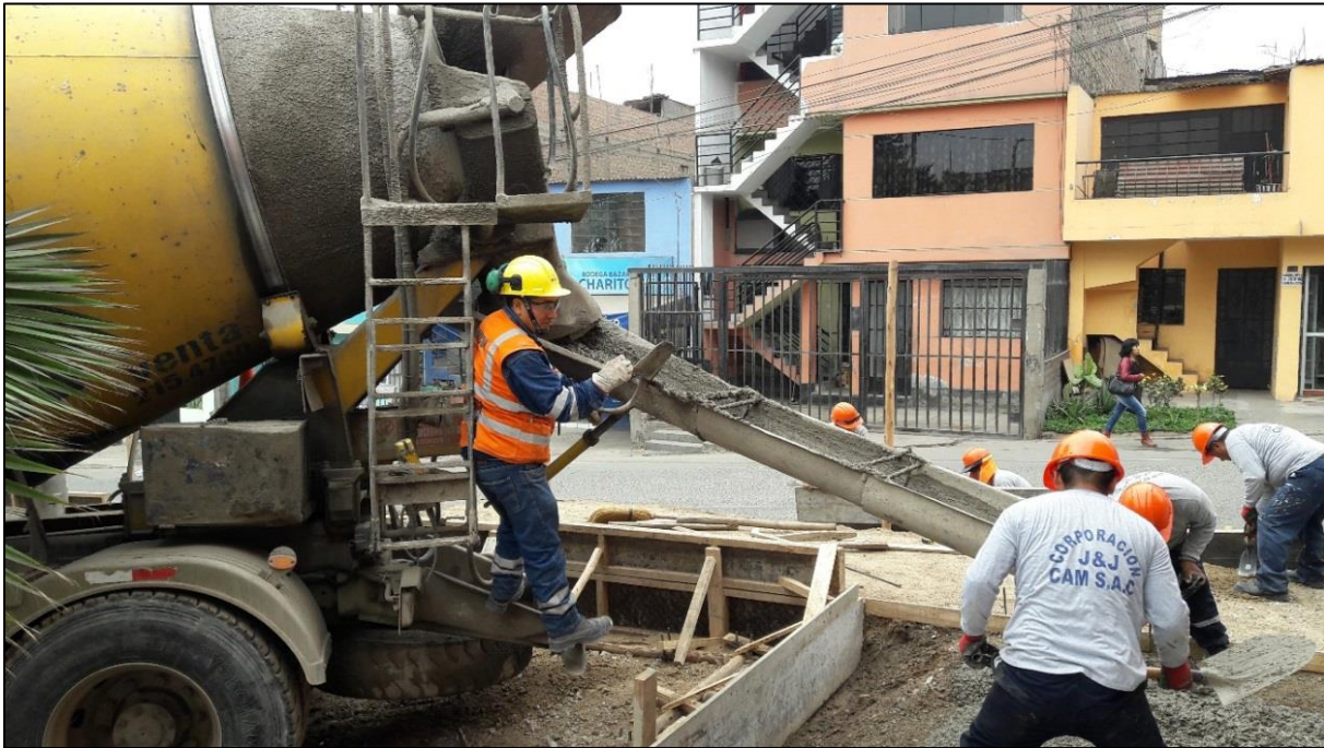
Figura N ° 9. Vaciado de concreto utilizando mezcladora e implementación de la gestión de proyectos del proyecto B. Autoría propia.
