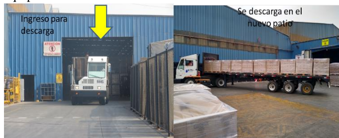
Fig. 10 Antes y después: ampliación de la zona de descarga
