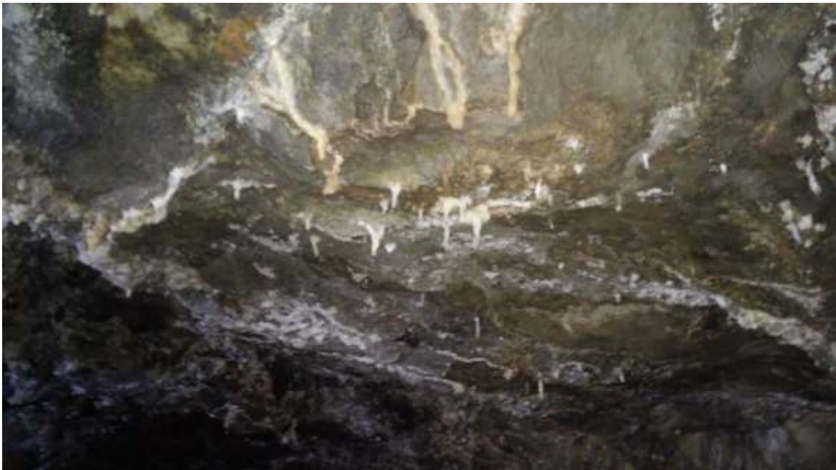
Figura 8: Estación geomecánica del macizo rocoso N°2.
