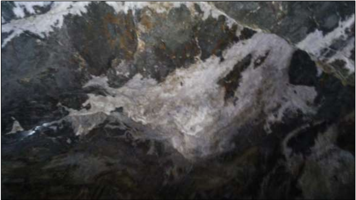
Figura 12: Estacion geomecánica n° 4.
