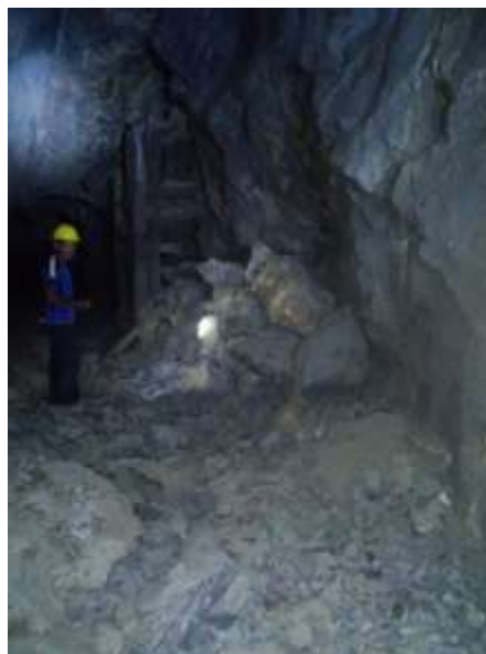
Figura 14: Desprendimiento de rocas.
