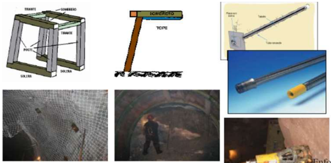
Figura 19: Elementos de sostenimiento en Zenit 1, en base la clasificación del RMR de Bieniawski.
