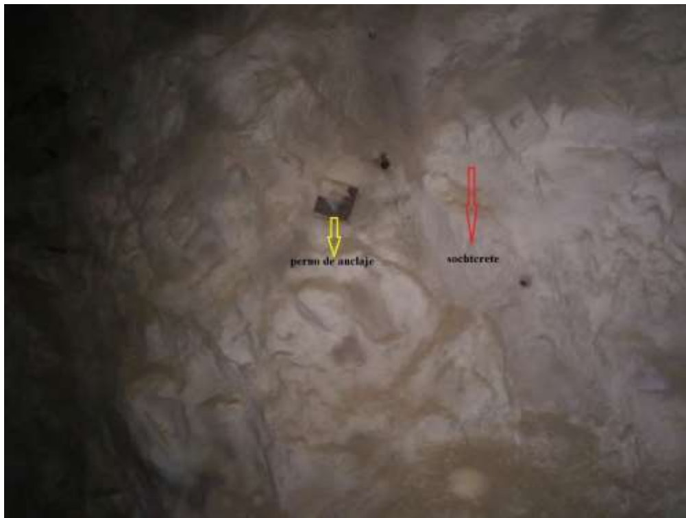
Figura 17: Shotcrete en la labor minera.
