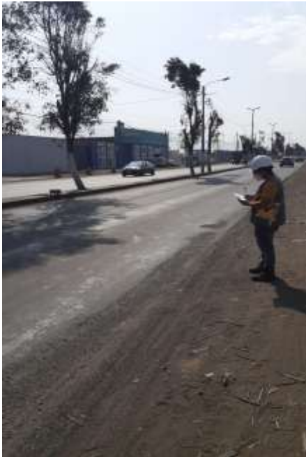
Pulimiento de agregados
