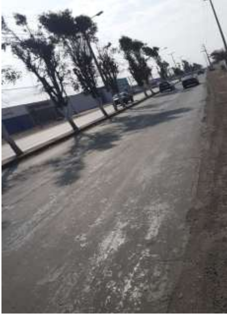
Pulimiento de agregados
