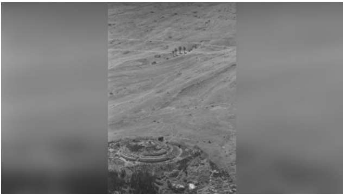
Ilustración 30 Vista de la ciudad de Yungay después del sismo.
