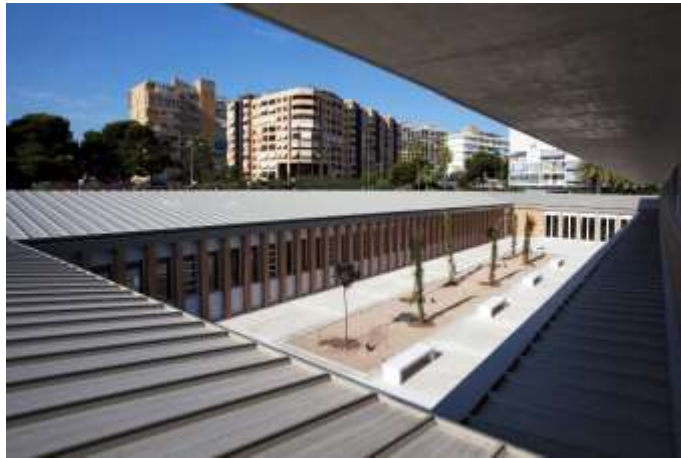
Figura 2. Vista exterior de centro educativo mediterráneo de Alicante
