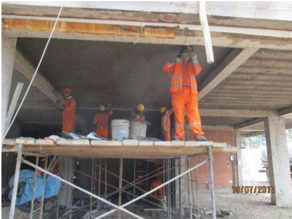
Fotografía 63. Avance en trabajos de la partida de tarrajeo en cielo raso.
