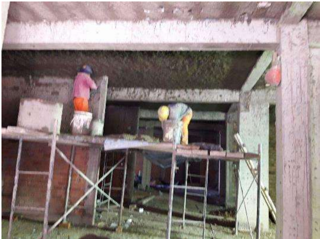
Fotografía 10. Avance de trabajos en la partida de tarrajeo en cielo raso.
