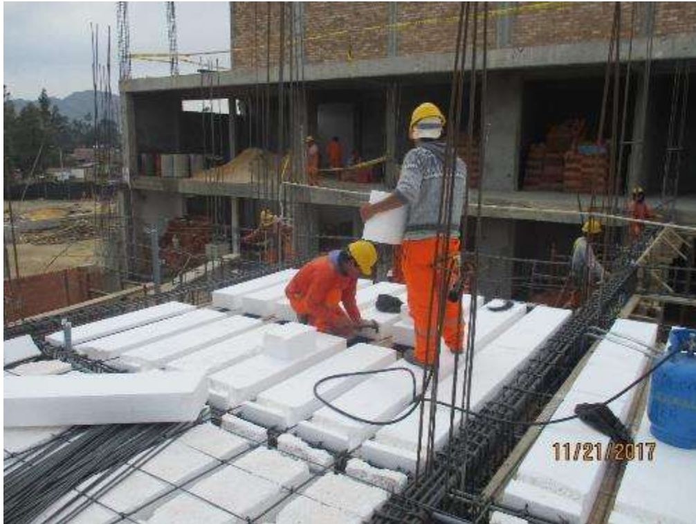
Fotografía 57. Avance de trabajos en la partida casetones en losa aligerada.
