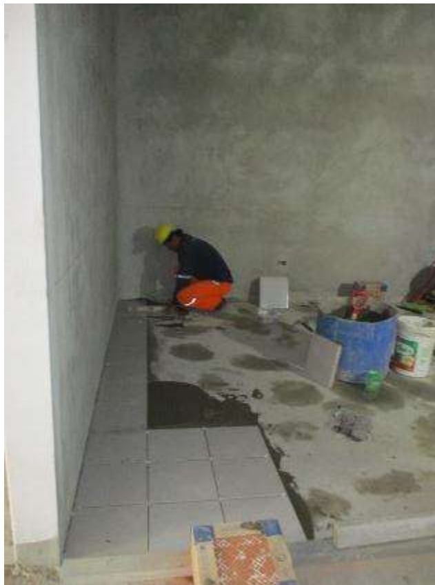
Fotografía 52. Avance de trabajos en la partida de piso cerámico.
