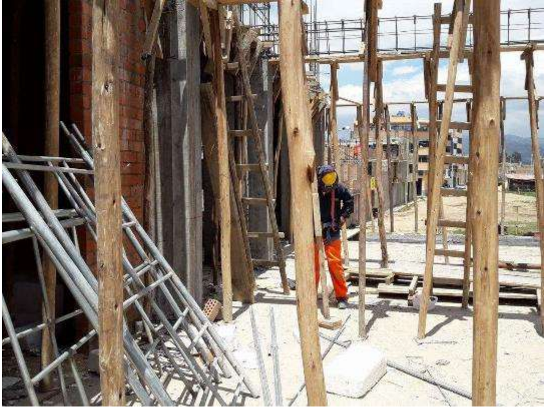
Fotografía 7. Avance de trabajos en la partida encofrado y desencofrado de losas aligeradas.
