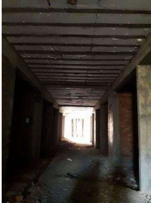
Fotografía 19. Avance de trabajos de desencofrados en losas aligeradas.
