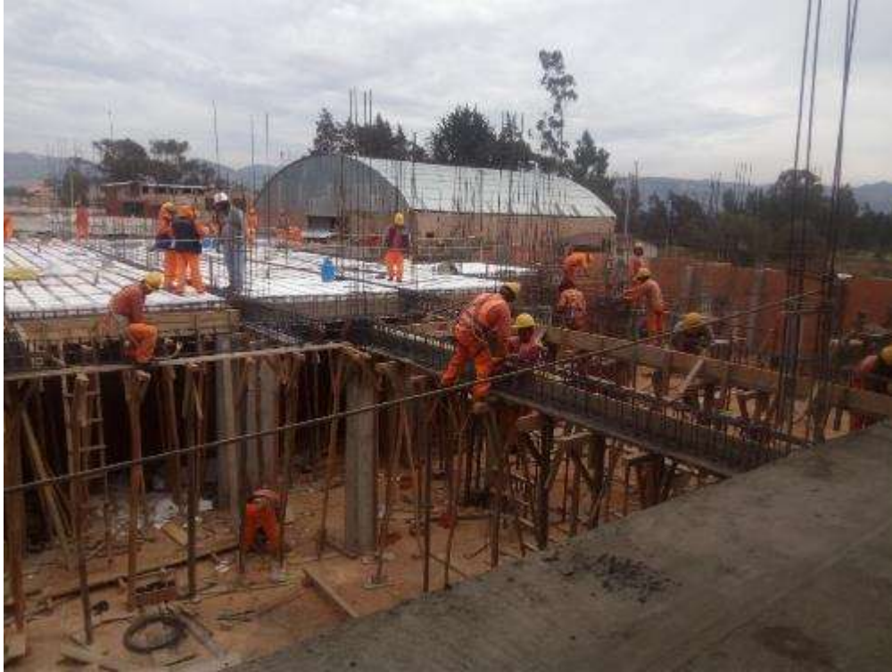
Fotografía 35. Avance de trabajos en la partida de casetones en losas aligeradas.
