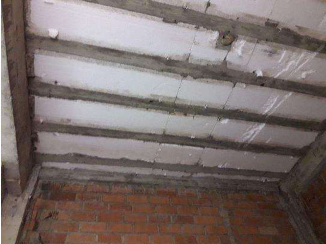
Fotografía 9. inicio de trabajos en la partida de tarrajeo en cielo raso.
