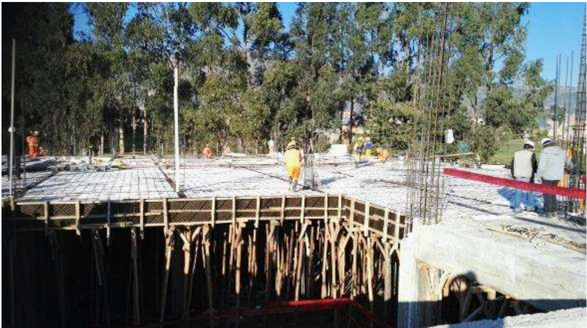
Fotografía 28. Avance de trabajos en la partida de concreto en losas aligeradas.
