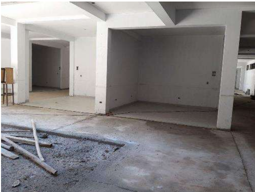
Fotografía 2. Avance de trabajos en la partida piso cerámico.
