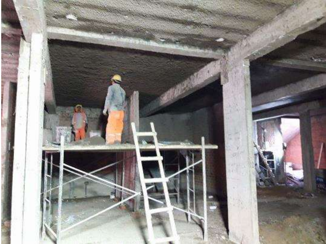
Fotografía 3. Avance de trabajos en la partida tarrajeo de cielo raso.
