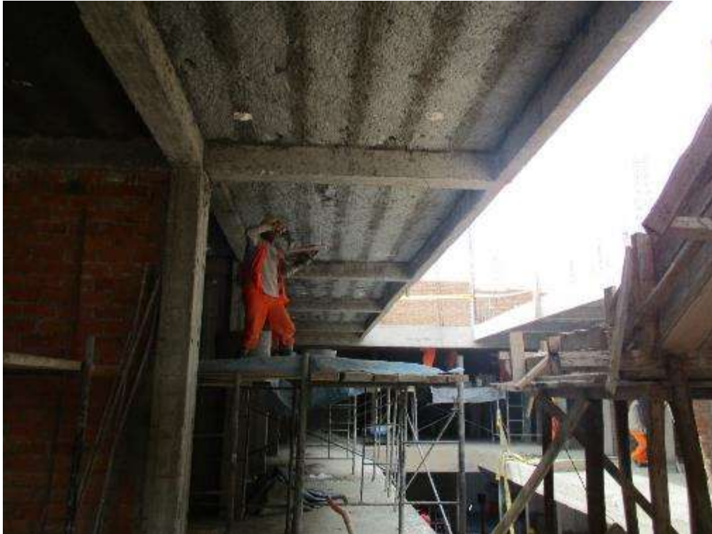
Fotografía 44. Avance de trabajos en la partida de tarrajeo de cielo raso.
