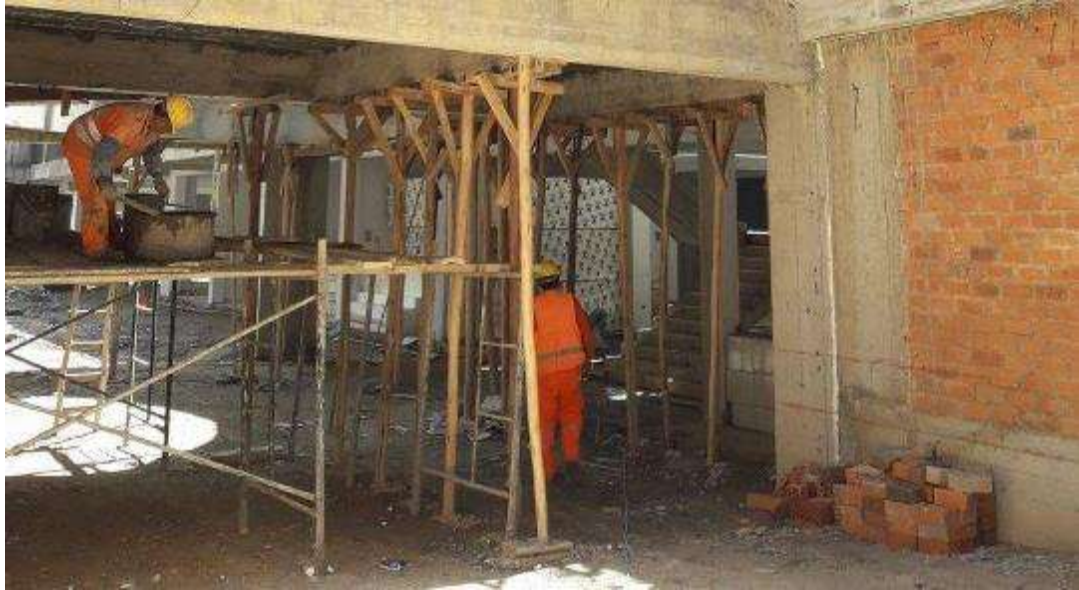
Fotografía 5. Avance de trabajos en la partida tarrajeo de cielo raso.
