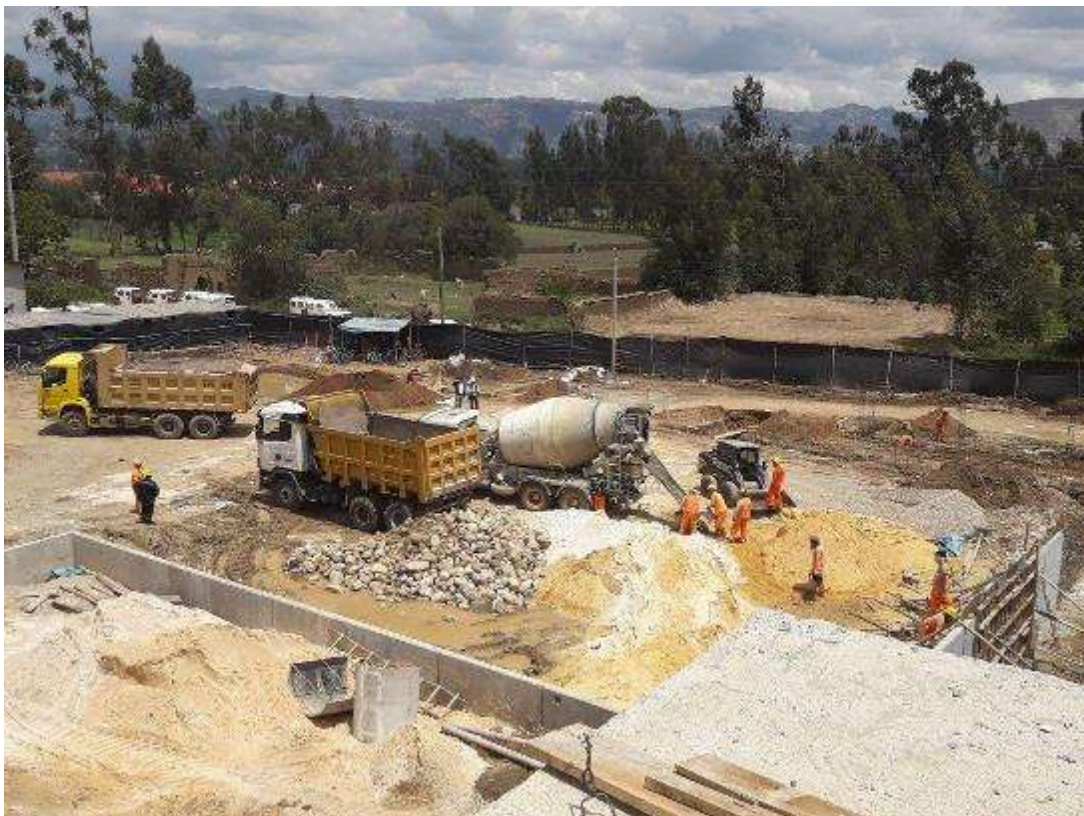
Fotografía 4. Equipos utilizados en la partida de concreto en losas aligeradas.
