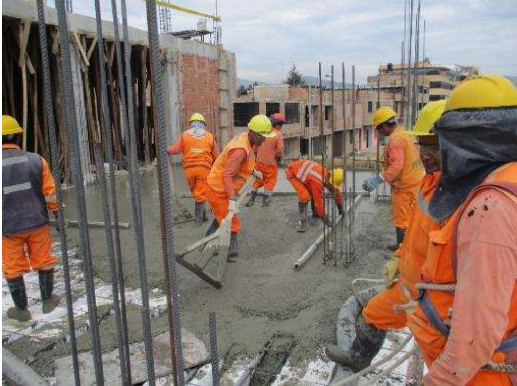
Fotografía 41. Avance de trabajos en la partida de concreto en losas aligeradas.
