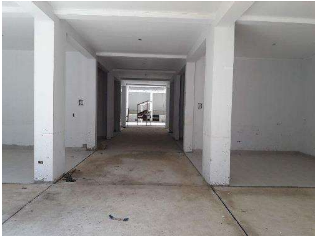
Fotografía 16. Avance de trabajos en piso cerámico.
