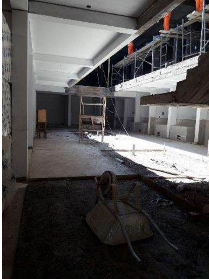
Fotografía 11. Avance de trabajos en la partida falso piso.
