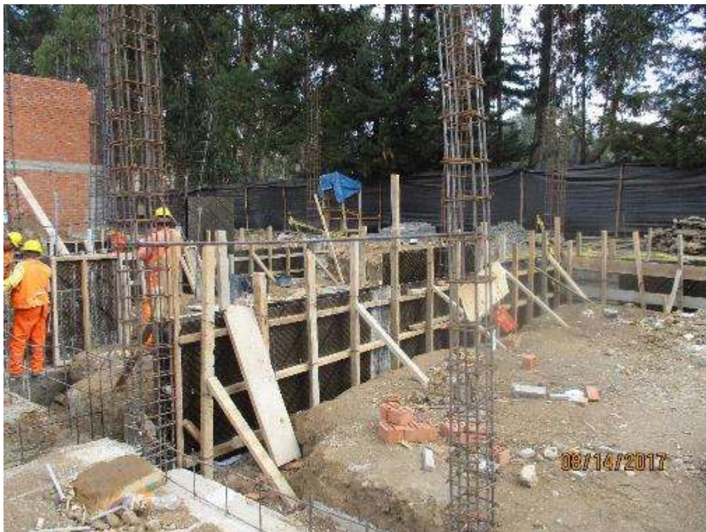
Fotografía 74. Avance de trabajos en la partida encofrados y desencofrados en sobrecimientos.
