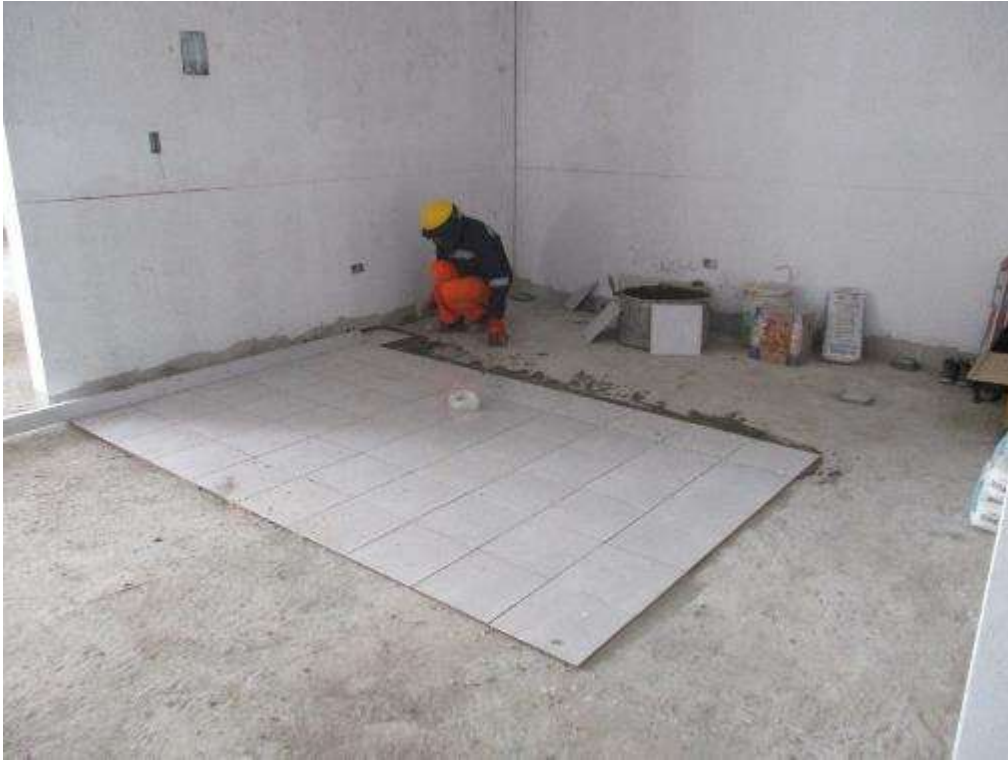
Fotografía 53. Avance de trabajos en la partida de piso cerámico.
