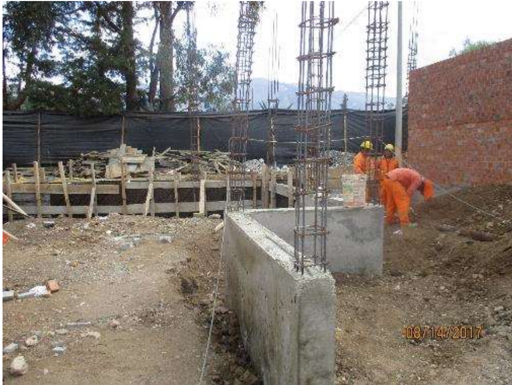
Fotografía 75. Avance de trabajos en la partida encofrados y desencofrados en sobrecimientos.
