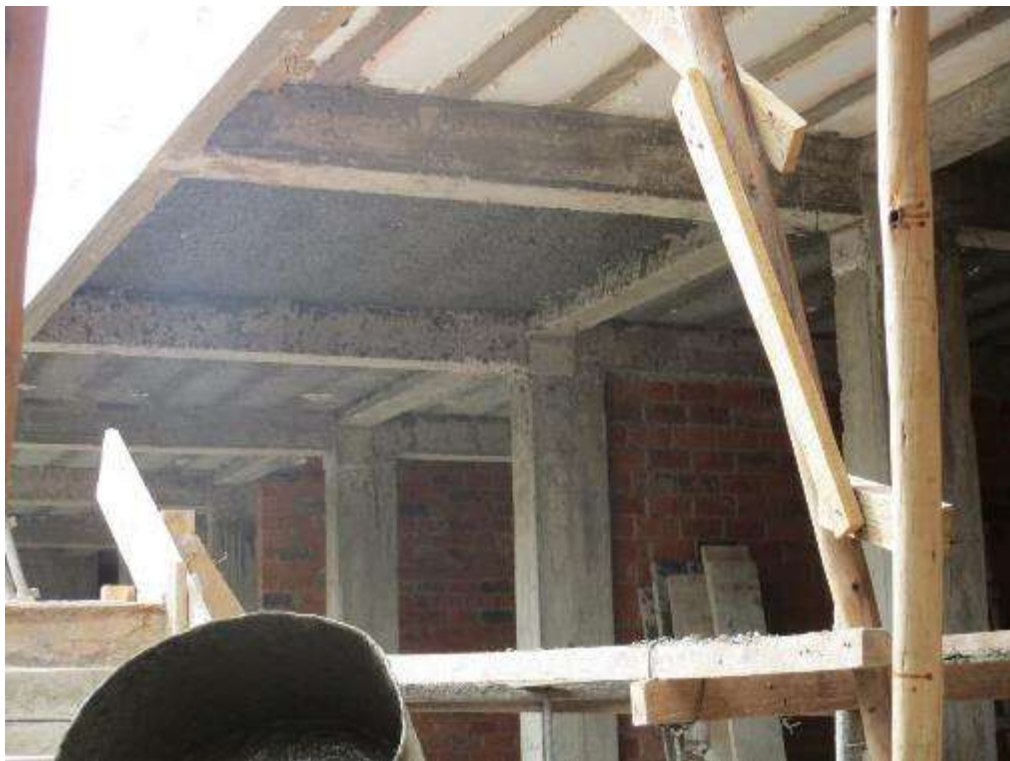
Fotografía 46. Avance de pañeteo en partida de tarrajeo en cielo raso.
