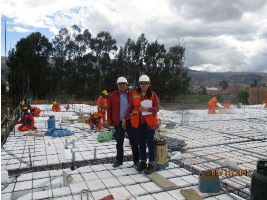
Fotografía 65. Tesista en segundo control de partida en losas aligeradas.
