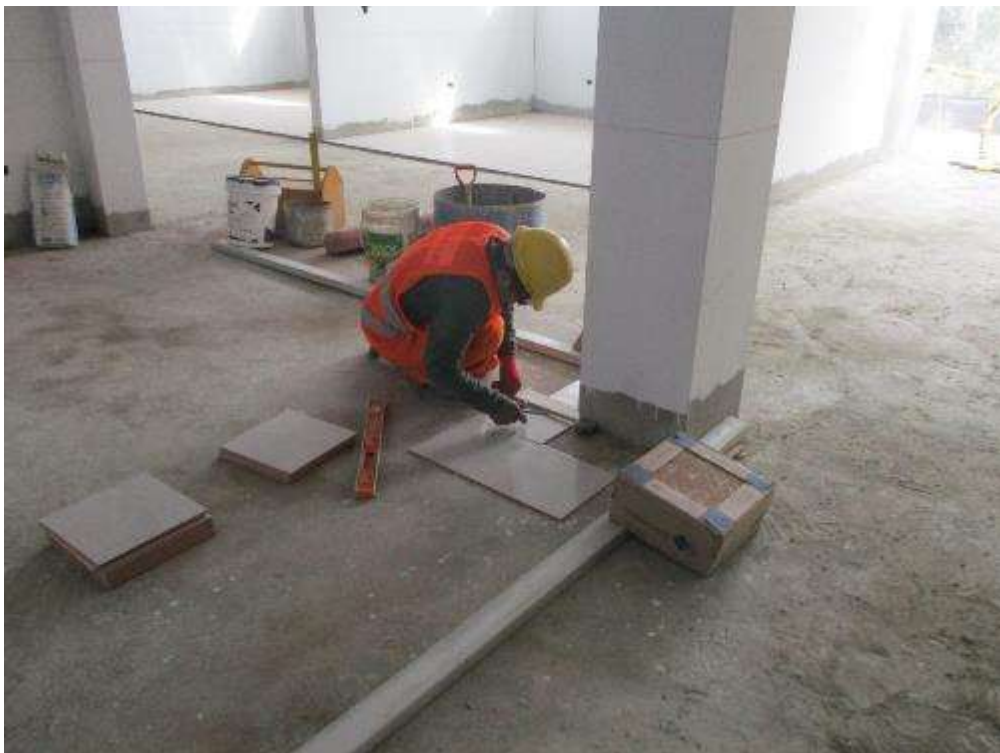
Fotografía 50. Avance de trabajos en la partida de piso cerámico.
