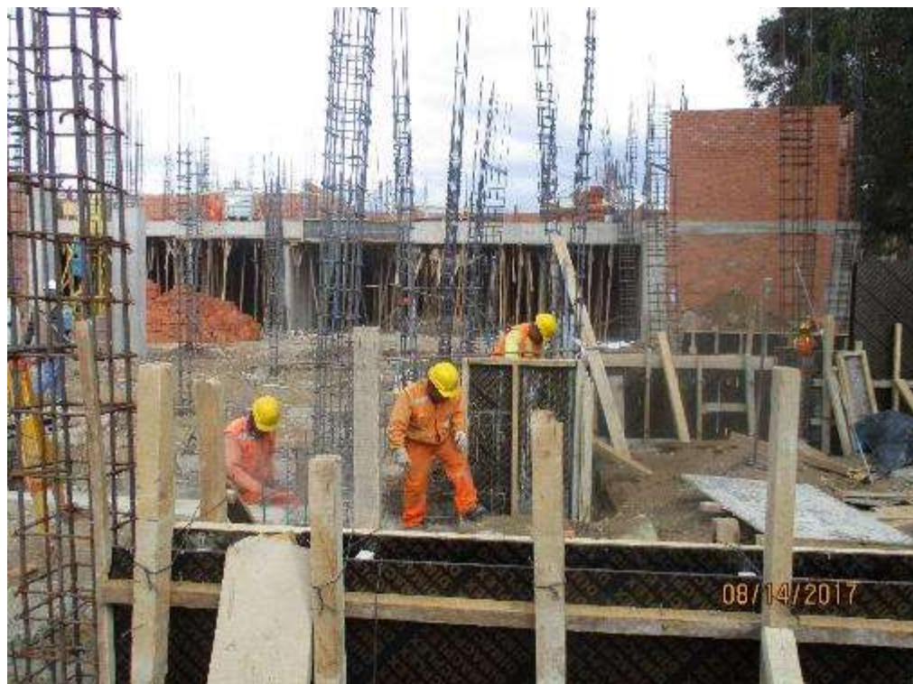
Fotografía 76. Avance de trabajos en la partida encofrados y desencofrados en sobrecimientos.
