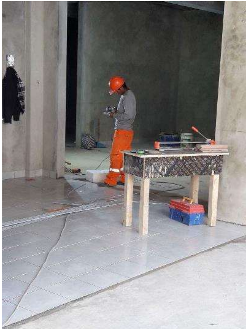
Fotografía 6. Avance de trabajos en la partida piso cerámico.
