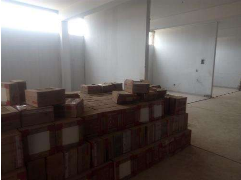
Fotografía 33. Avance de trabajos en la partida de piso cerámico.
