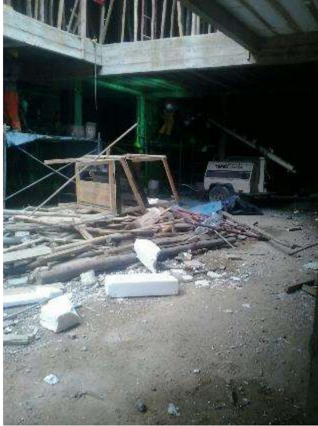
Fotografía 29. Avance de trabajos en la partida de tarrajeo de cielo raso.
