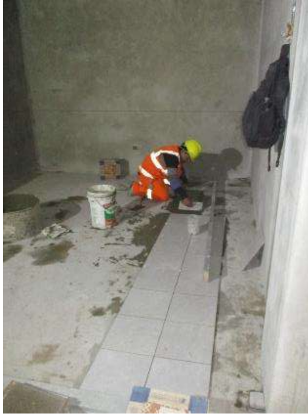
Fotografía 51. Avance de trabajos en la partida de piso cerámico.
