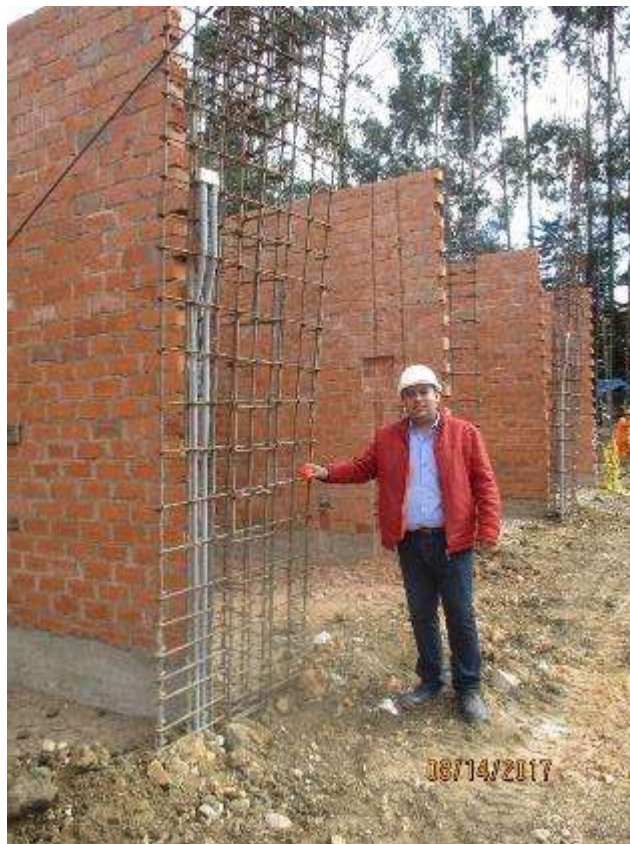
Fotografía 78. Tesista en visita a obra.
