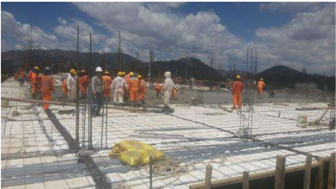
Fotografía 32. Avance de trabajos en la partida de concreto en losas aligeradas.
