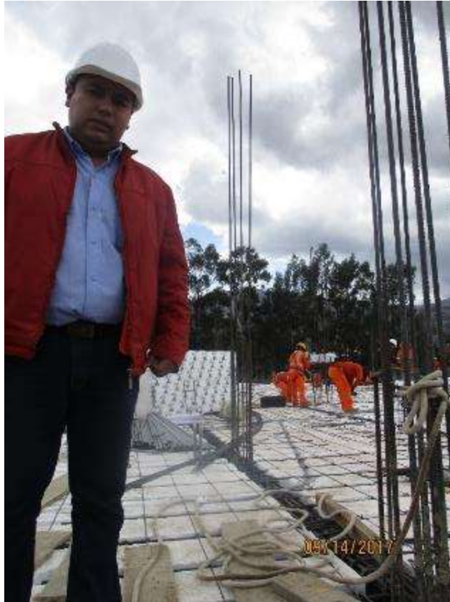
Fotografía 69. tesista en control de partida casetones en losas aligeradas.
