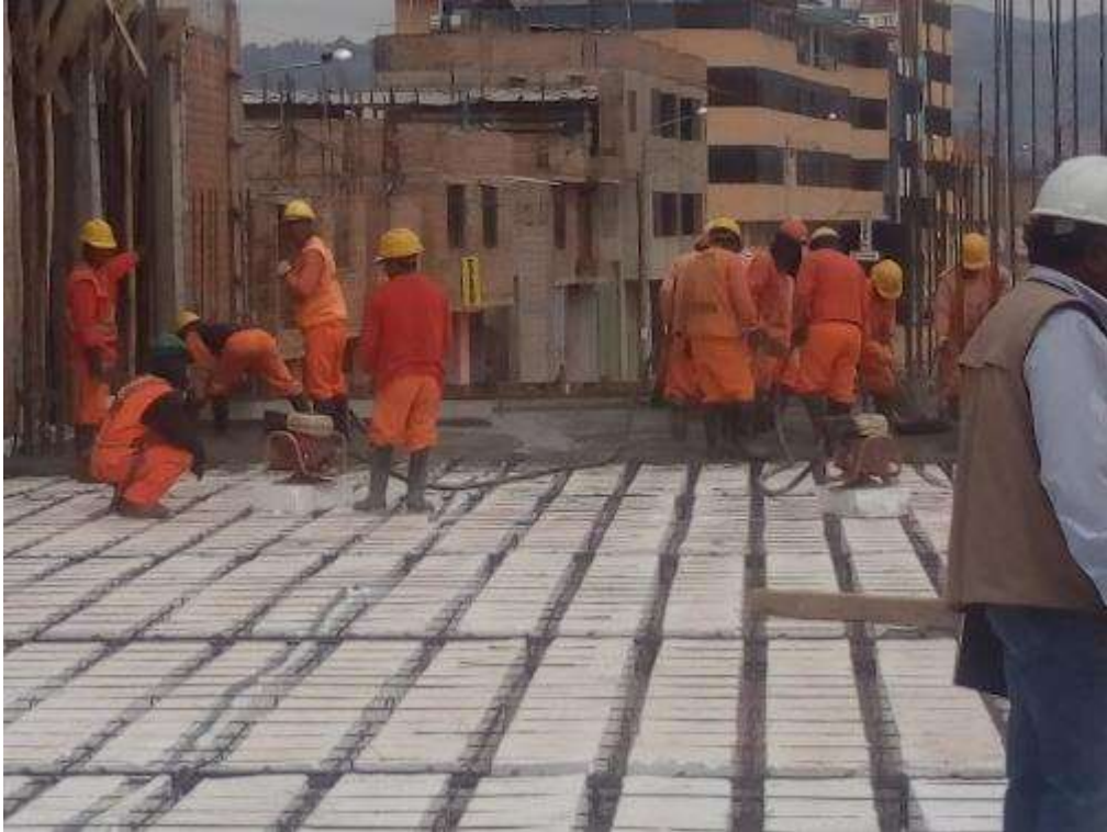
Fotografía 37. Avance de trabajos en la partida de concreto en losas aligeradas.
