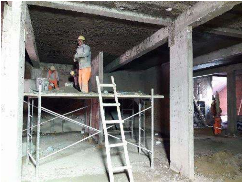
Fotografía 24. Avance de trabajos en la partida de tarrajeo de cielo raso.
