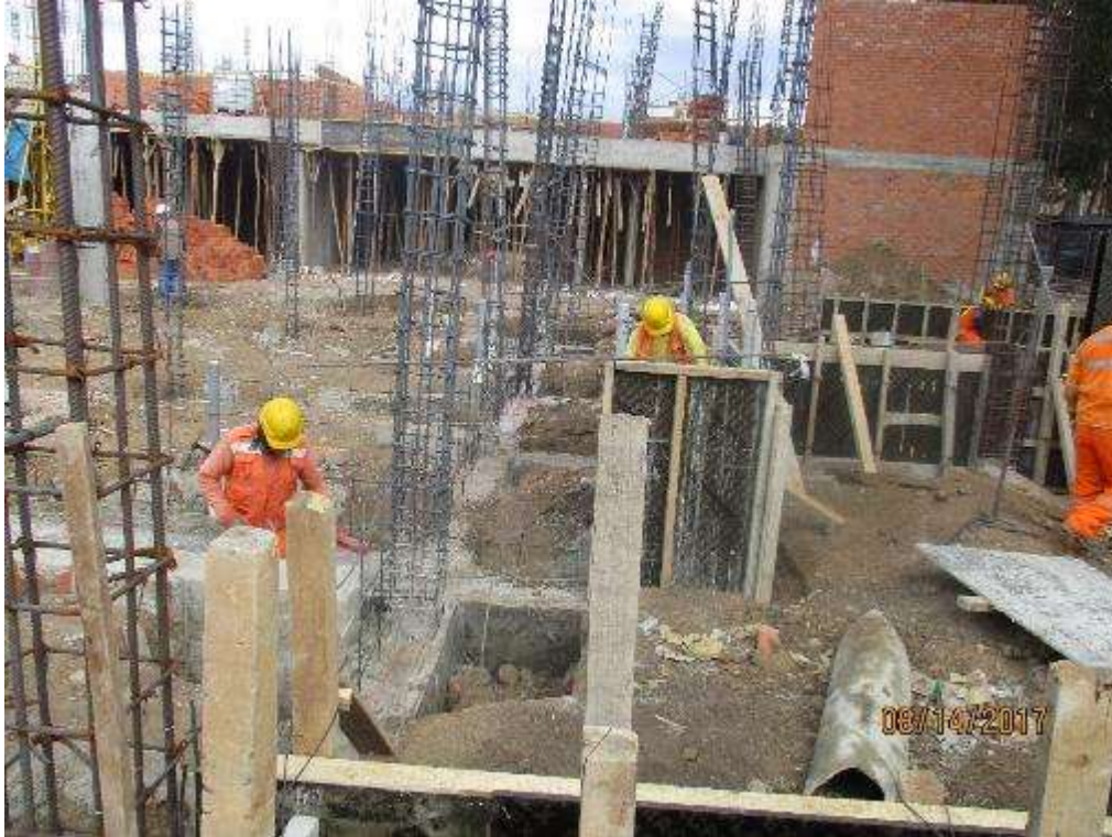
Fotografía 77. Avance de trabajos en la partida encofrados y desencofrados en sobrecimientos.
