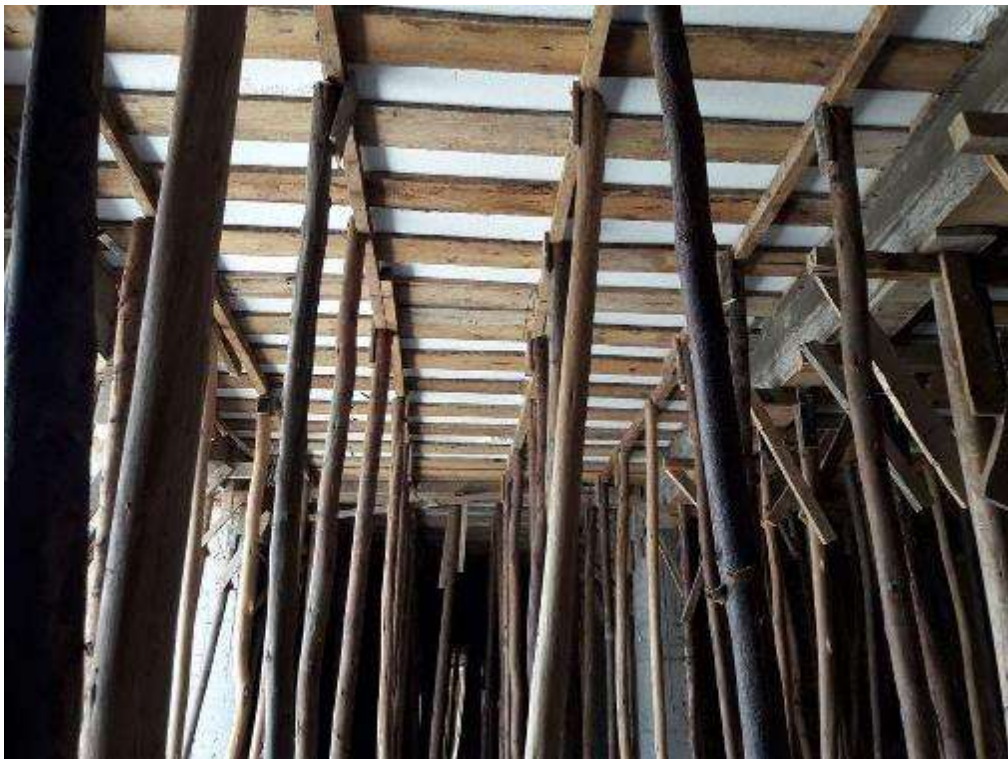
Fotografía 18. inicio de trabajos de desencofrados en losas aligeradas.
