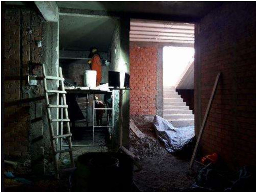
Fotografía 22. Avance de trabajos en la partida de tarrajeo de cielo raso.
