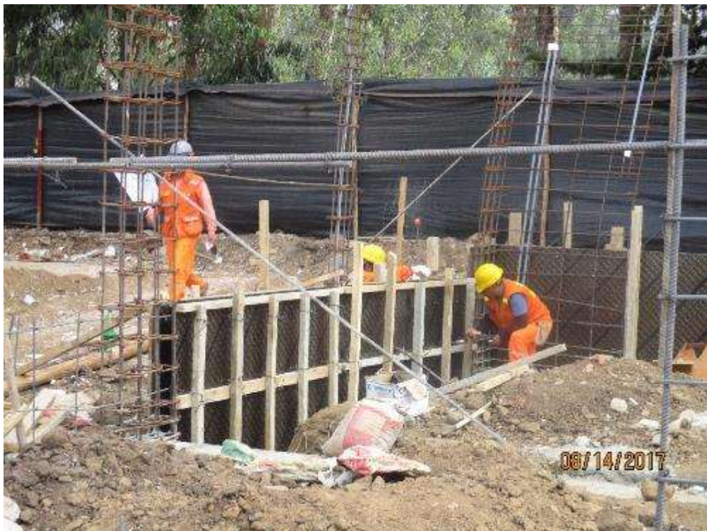
Fotografía 80. Avance de trabajos en la partida encofrados y desencofrados en sobrecimientos.
