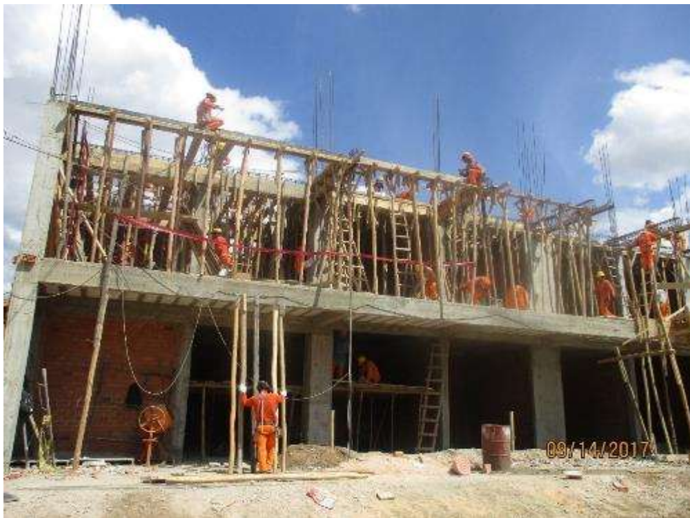
Fotografía 72. Avance de trabajos en la partida encofrado en losas aligeradas.
