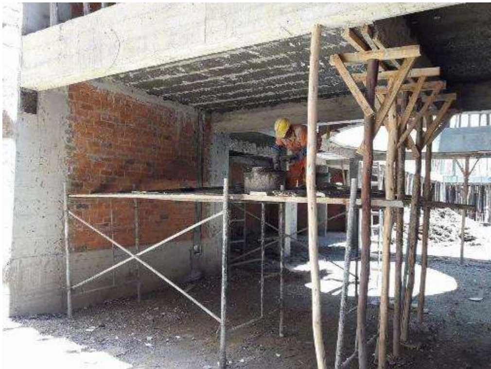
Fotografía 20. Avance de trabajos en la partida de tarrajeo de cielo raso.
