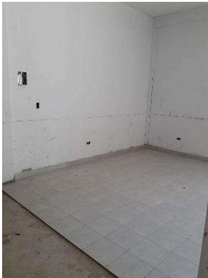
Fotografía 14. Avance de trabajos en piso cerámico.
