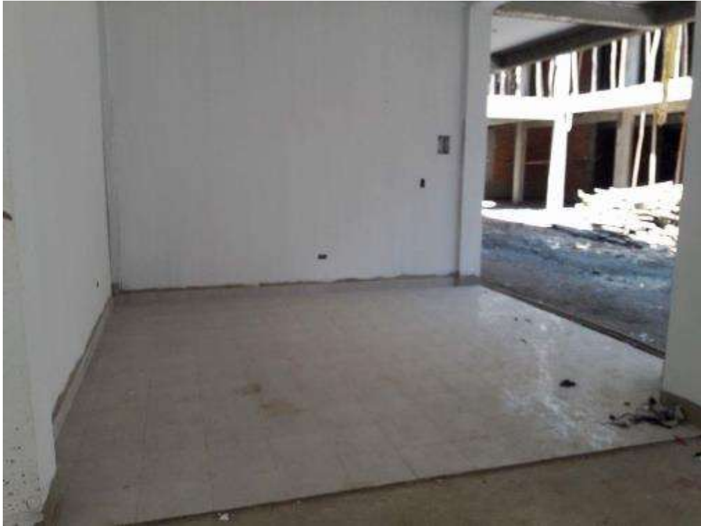
Fotografía 17. Avance de trabajos en piso cerámico.
