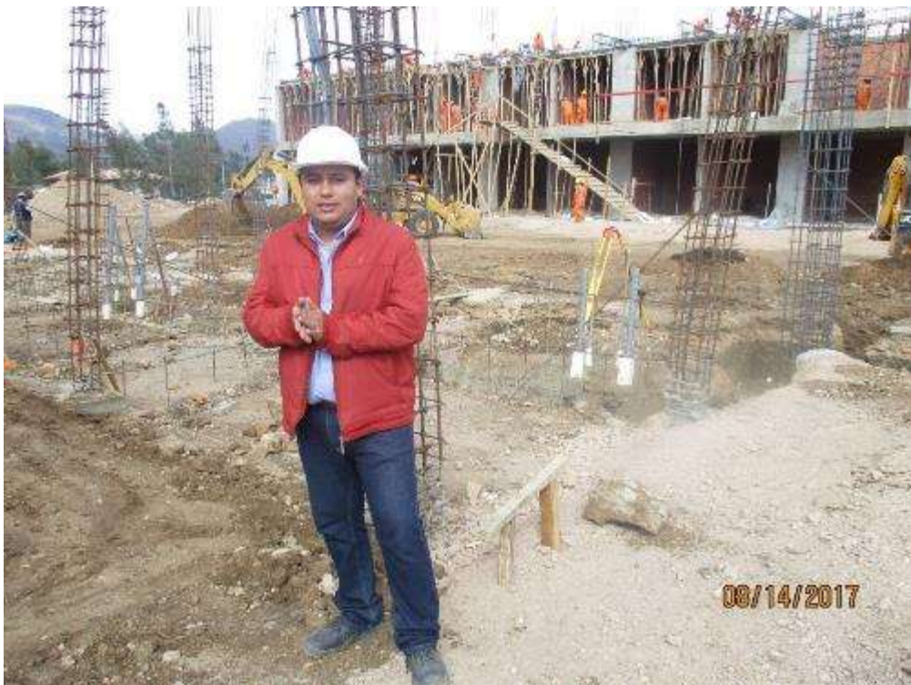
Fotografía 64. Tesista en visita a obra.
