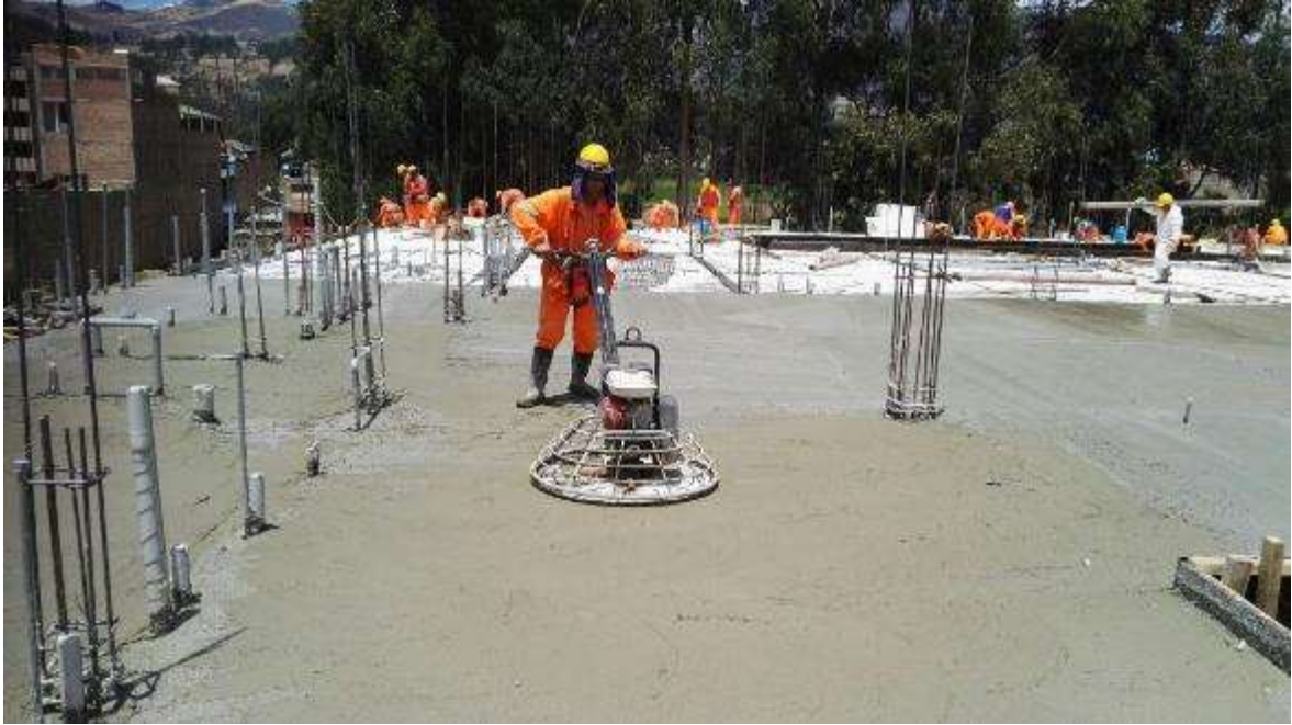
Fotografía 27. Avance de trabajos en la partida de concreto en losas aligeradas.
