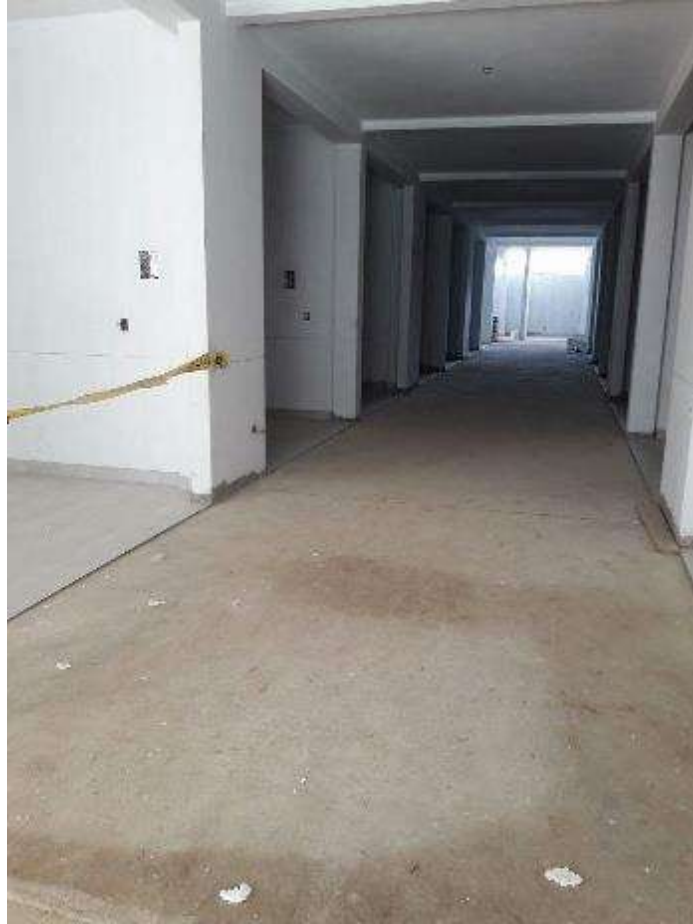
Fotografía 23. Avance de trabajos en la partida de piso cerámico.
