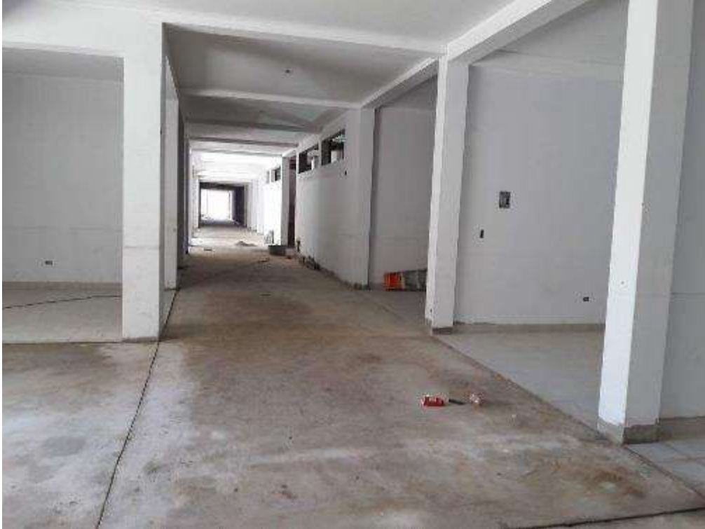
Fotografía 13. Avance de trabajos en piso cerámico.
