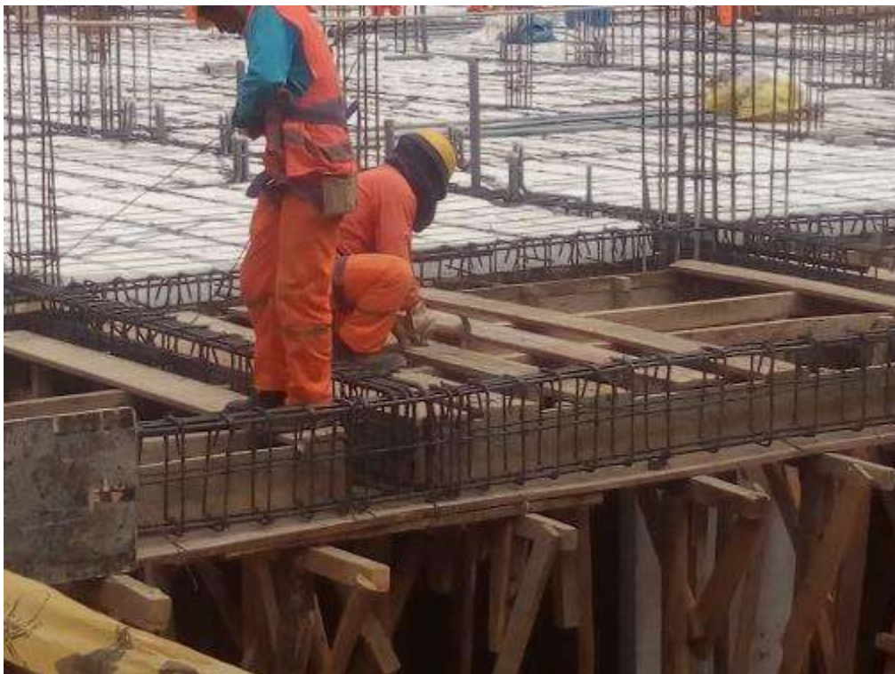
Fotografía 36. Avance de trabajos en la partida de casetones en losas aligeradas.
