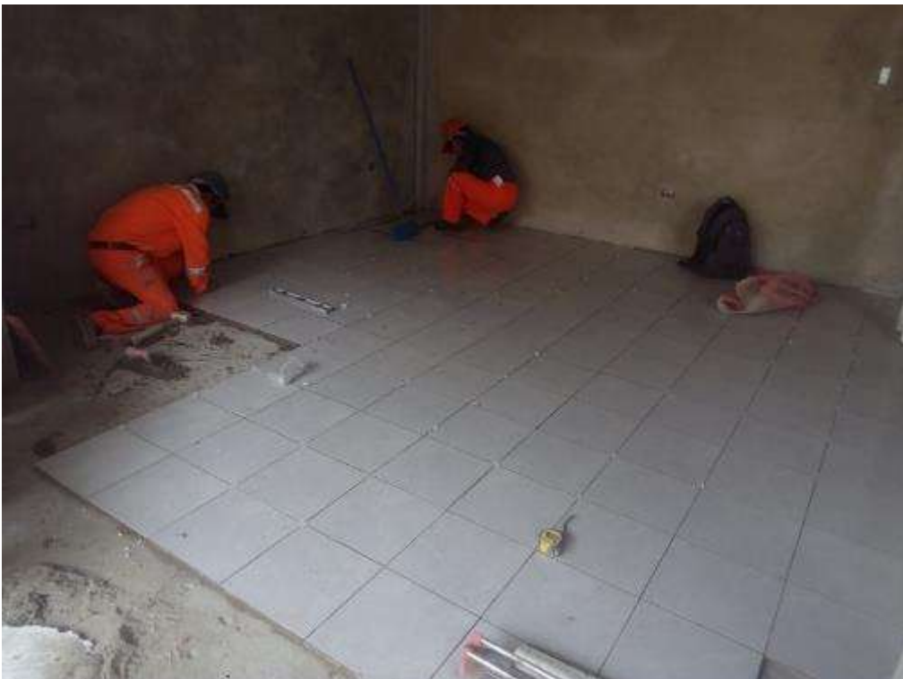
Fotografía 38. Avance de trabajos en la partida de piso cerámico.
