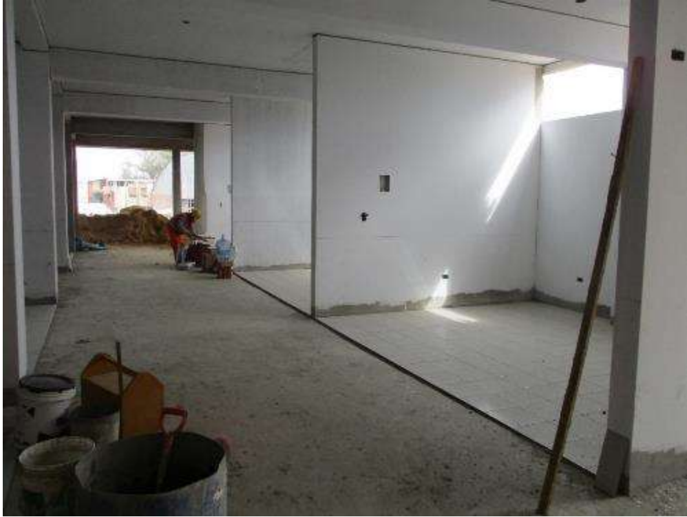
Fotografía 49. Avance de trabajos en la partida de piso cerámico.
