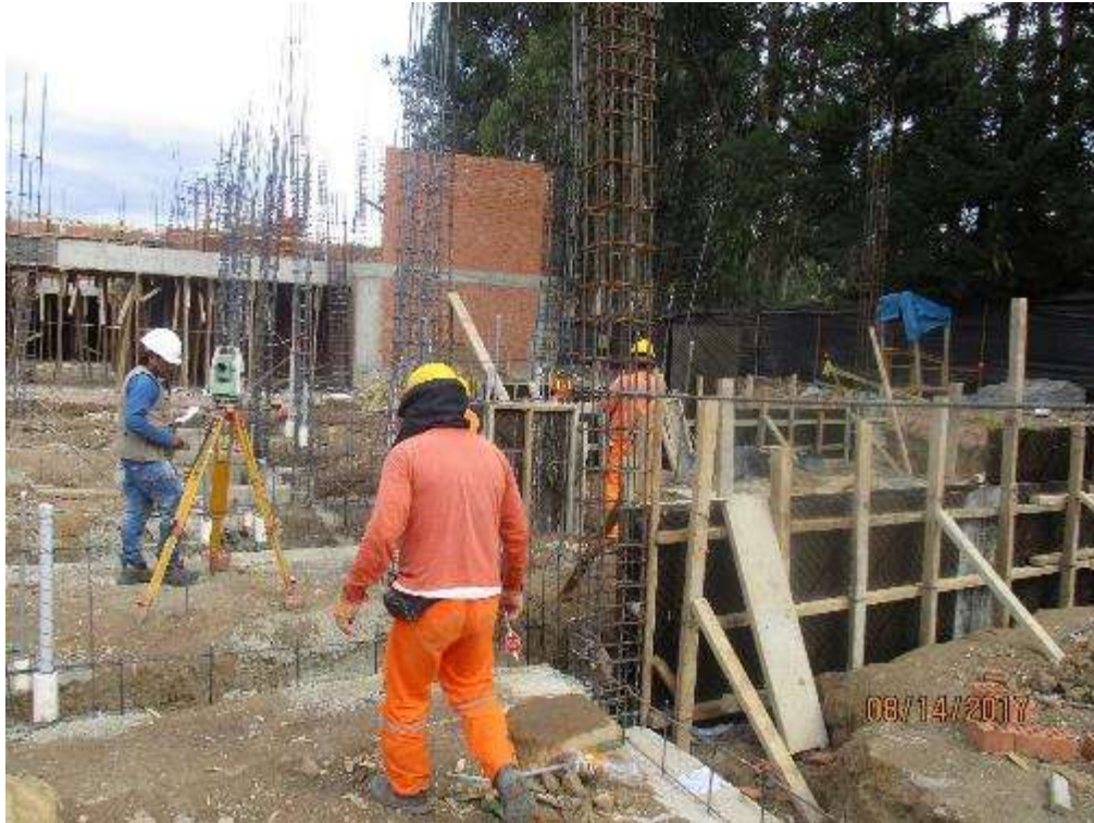
Fotografía 73. Avance de trabajos en la partida encofrados y desencofrados en sobrecimientos.
