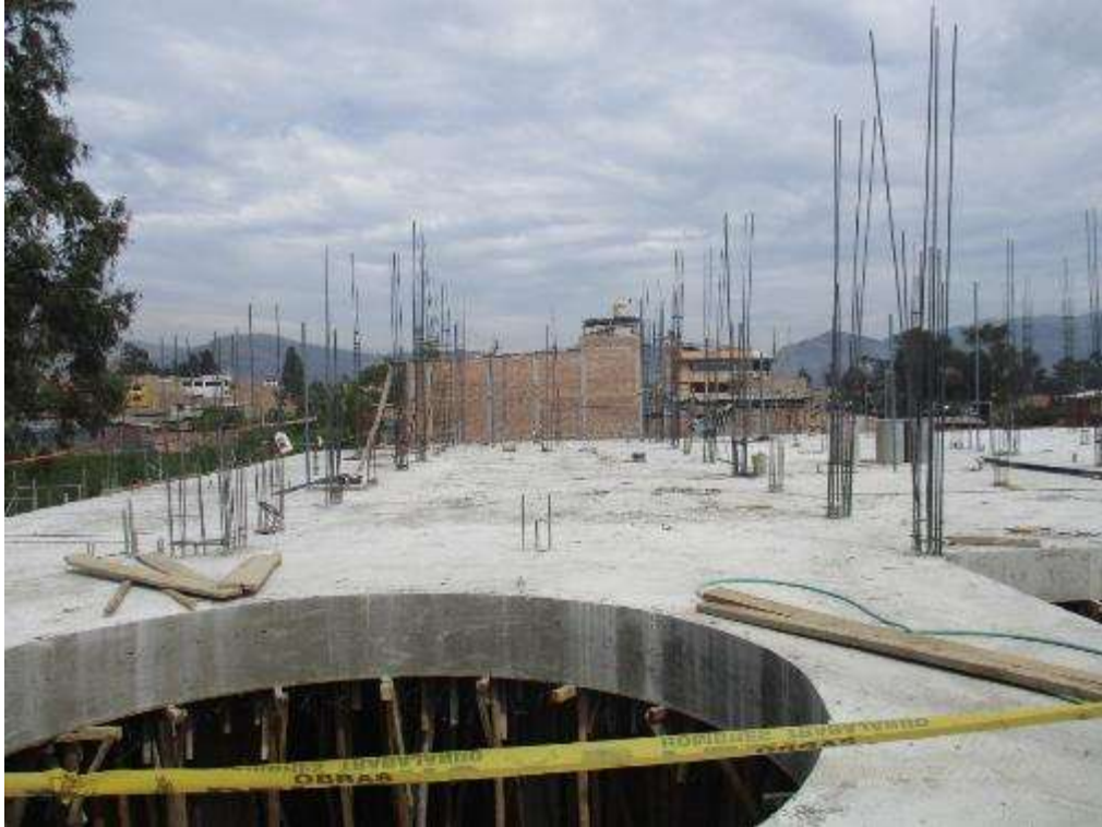
Fotografía 43. Avance de trabajos en la partida de concreto en losas aligeradas.
