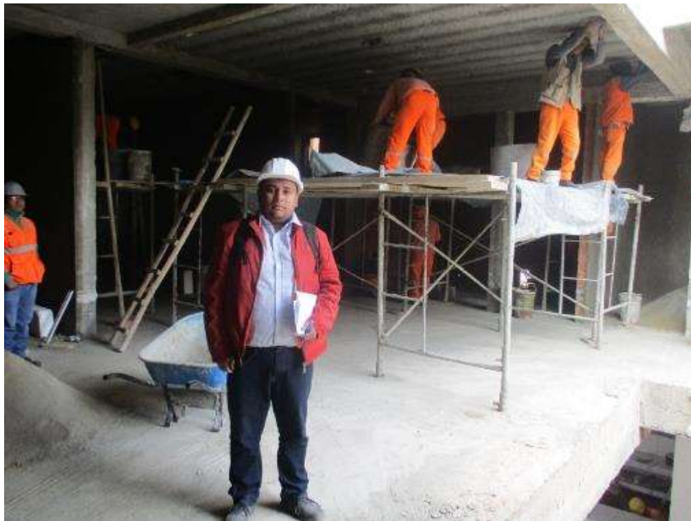
Fotografía 56. Avance del pañeteo en la partida de tarrajeo en cielo raso.
