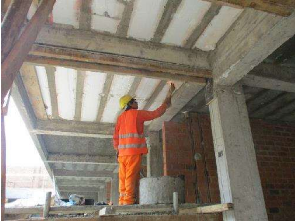
Fotografía 45. Preparación de superficie de trabajo para tarrajeo de cielo raso.
