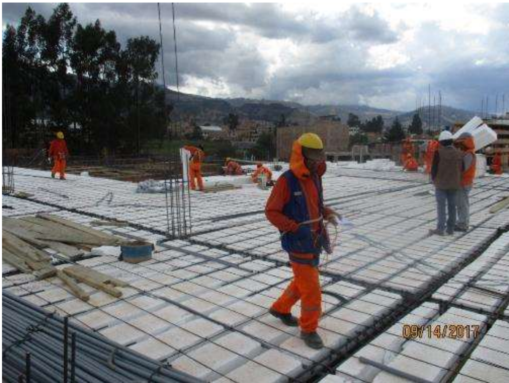
Fotografía 66. Avance de trabajos en la partida casetones en losas aligeradas.
