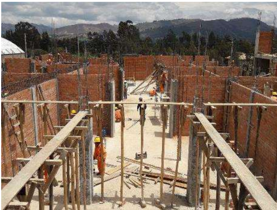
Fotografía 12. Inicio de trabajos de encofrado y desencofrado en losas aligeradas.
