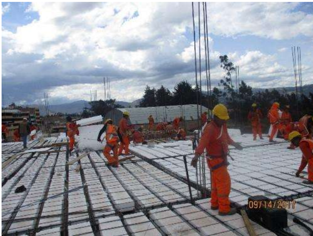
Fotografía 68. Avance de trabajos en la partida casetones en losas aligeradas.
