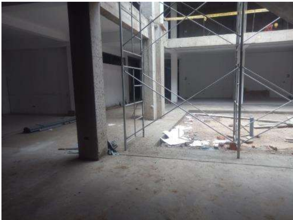
Fotografía 34. Avance de trabajos en la partida de falso piso.
