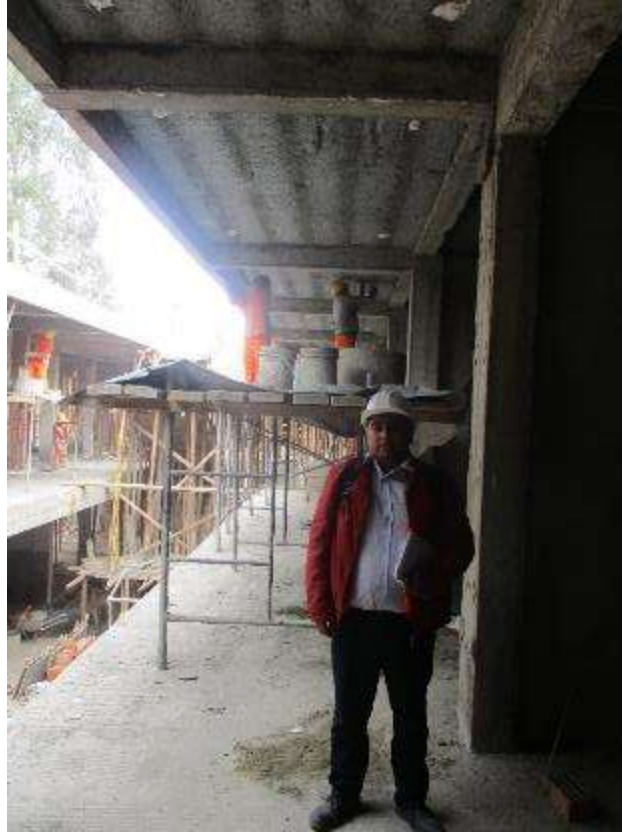
Fotografía 55. Avance del pañeteo en la partida de tarrajeo en cielo raso.
