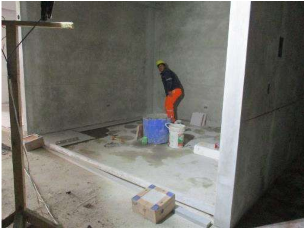
Fotografía 54. Avance de trabajos en la partida de piso cerámico.
