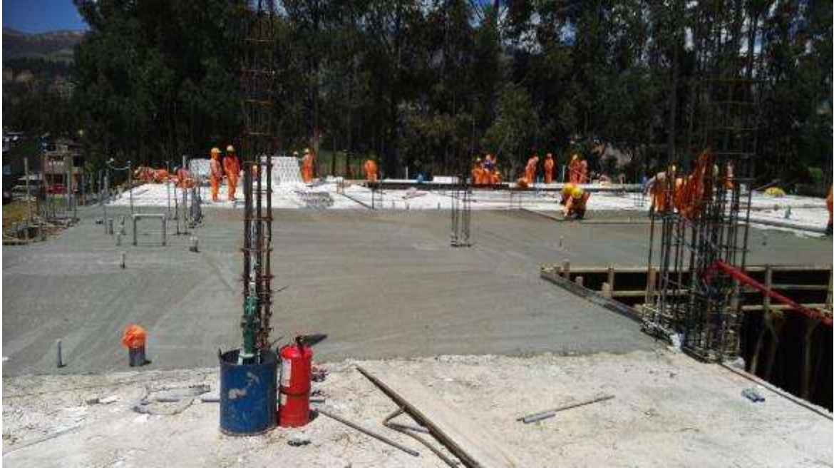
Fotografía 25. Avance de trabajos en la partida de concreto en losas aligeradas.
