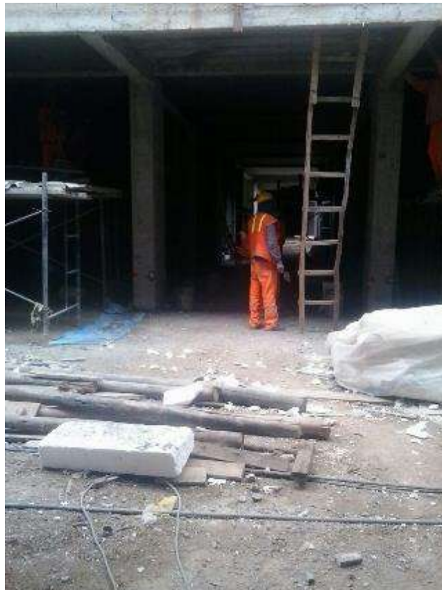
Fotografía 30. Avance de trabajos en la partida de tarrajeo de cielo raso.
