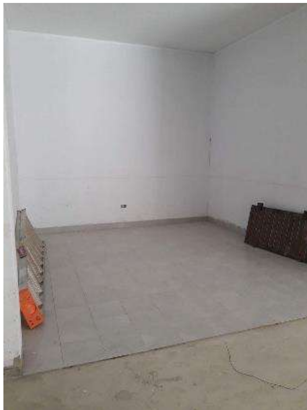
Fotografía 8. Avance de trabajos en la partida piso cerámico.
