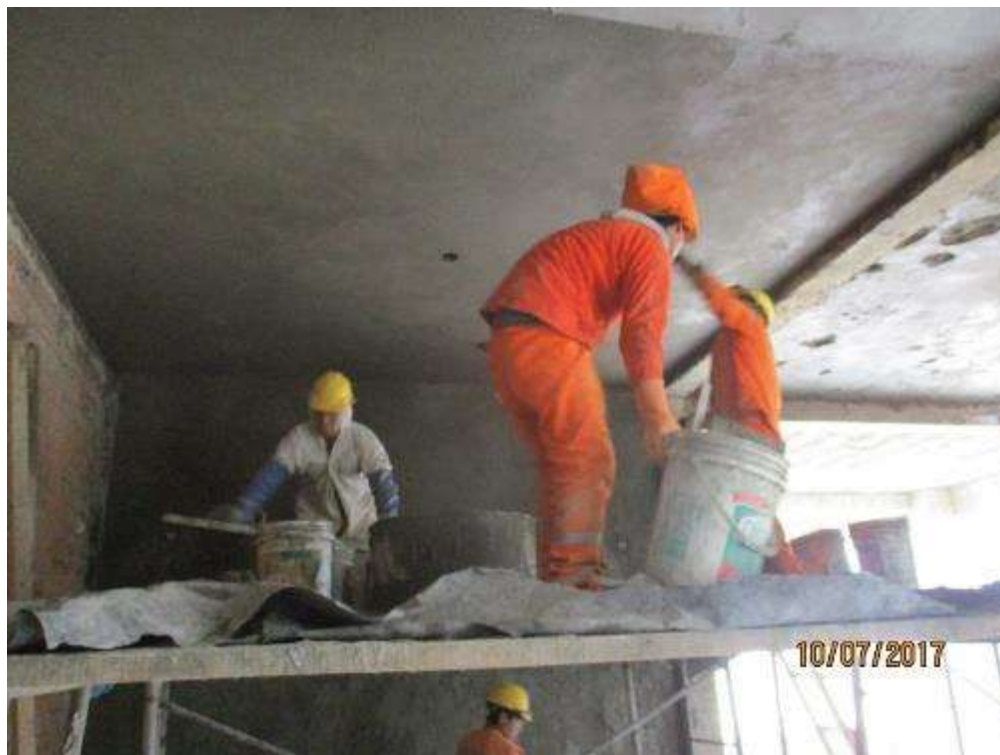
Fotografía 62. Avance en trabajos de la partida de tarrajeo en cielo raso.
