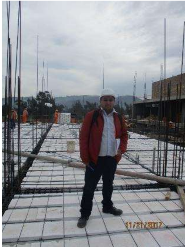
Fotografía 59. Tesista realizando control de las partidas de losas aligeradas.
