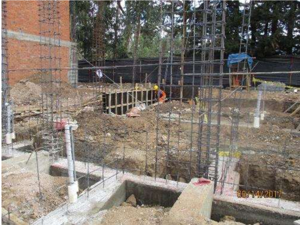
Fotografía 79. Avance de trabajos en la partida encofrados y desencofrados en sobrecimientos.
