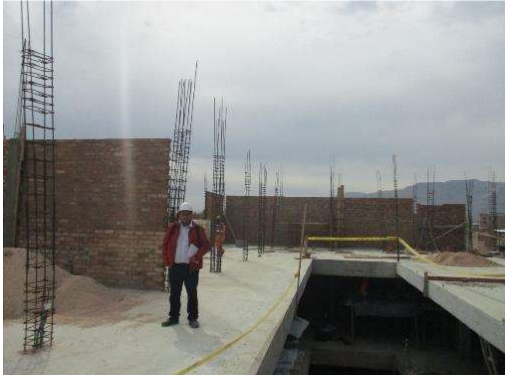
Fotografía 42. Tesista en visita a obra.
