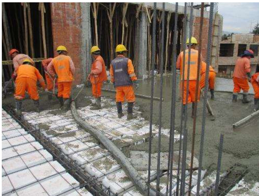
Fotografía 40. Avance de trabajos en la partida de concreto en losas aligeradas.
