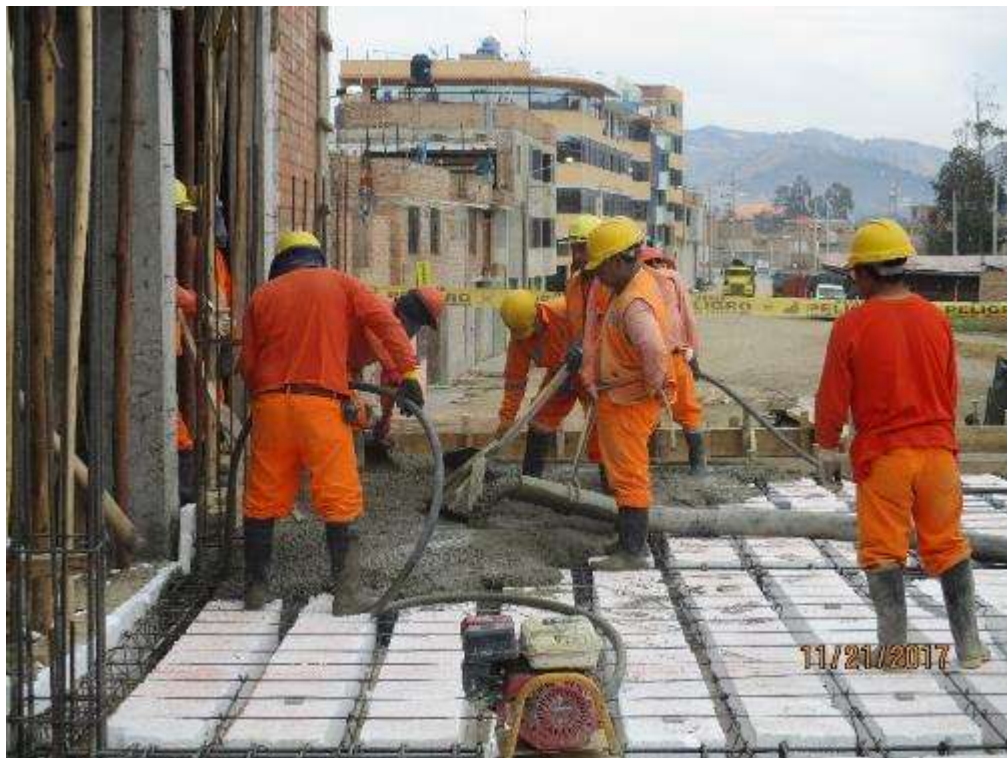
Fotografía 60. Avance de trabajos en la partida concreto en losas aligeradas.
