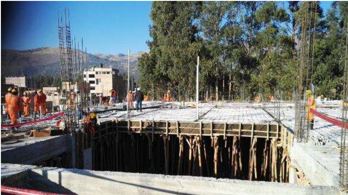
Fotografía 26. Avance de trabajos en la partida de concreto en losas aligeradas.
