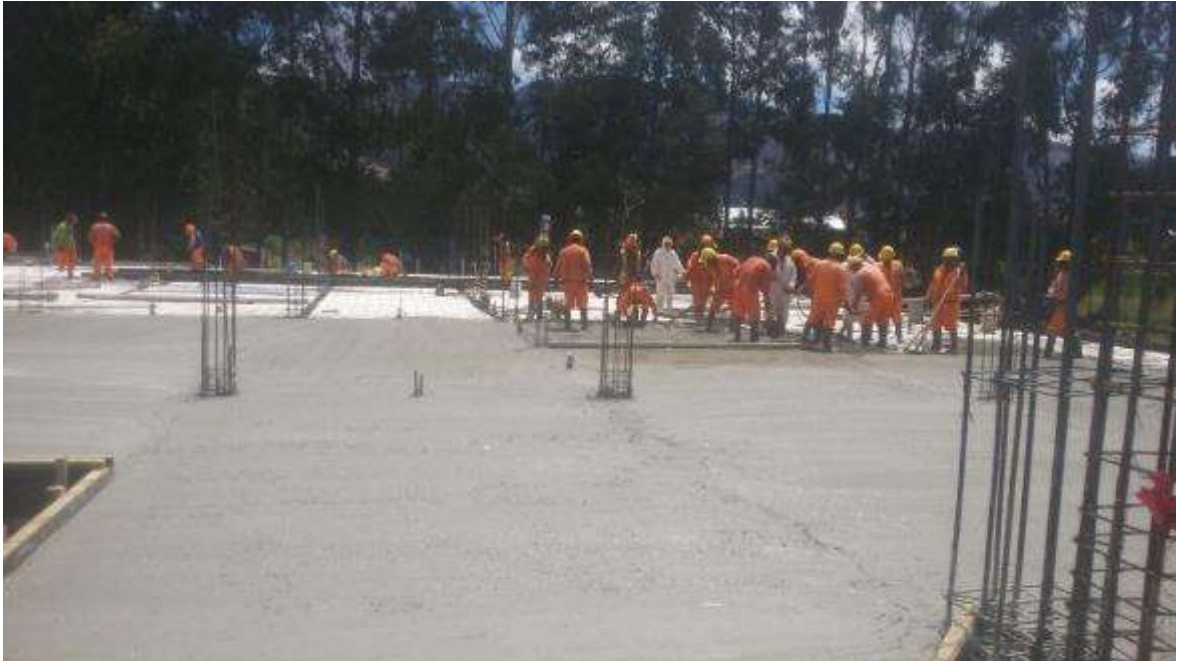
Fotografía 31. Avance de trabajos en la partida de concreto en losas aligeradas.
