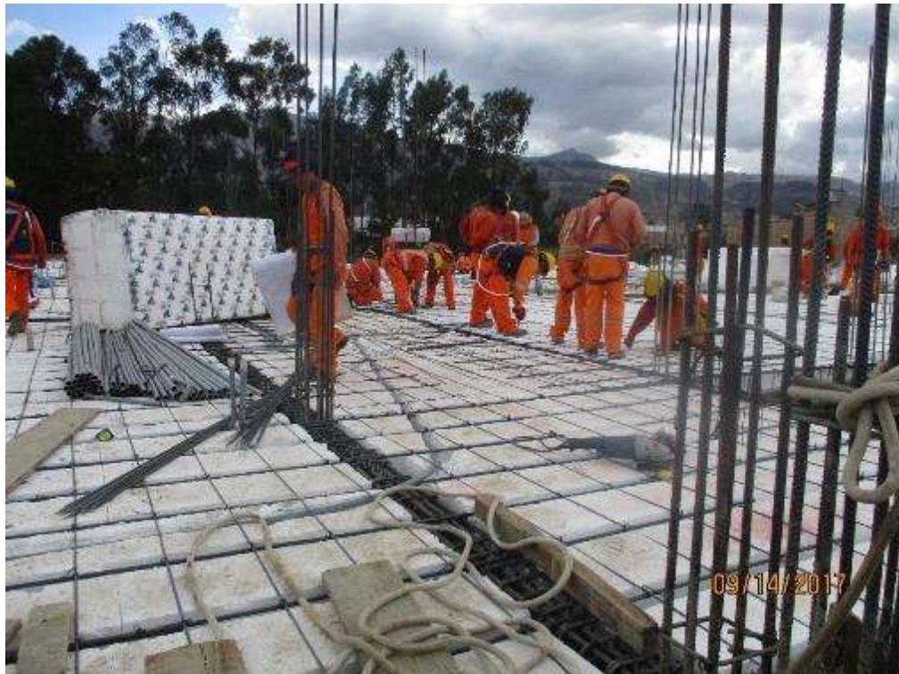
Fotografía 70. Avance de trabajos en la partida casetones en losas aligeradas.
