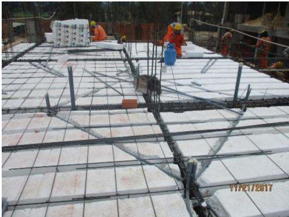
Fotografía 58. Avance de trabajos en la partida casetones en losa aligerada.
