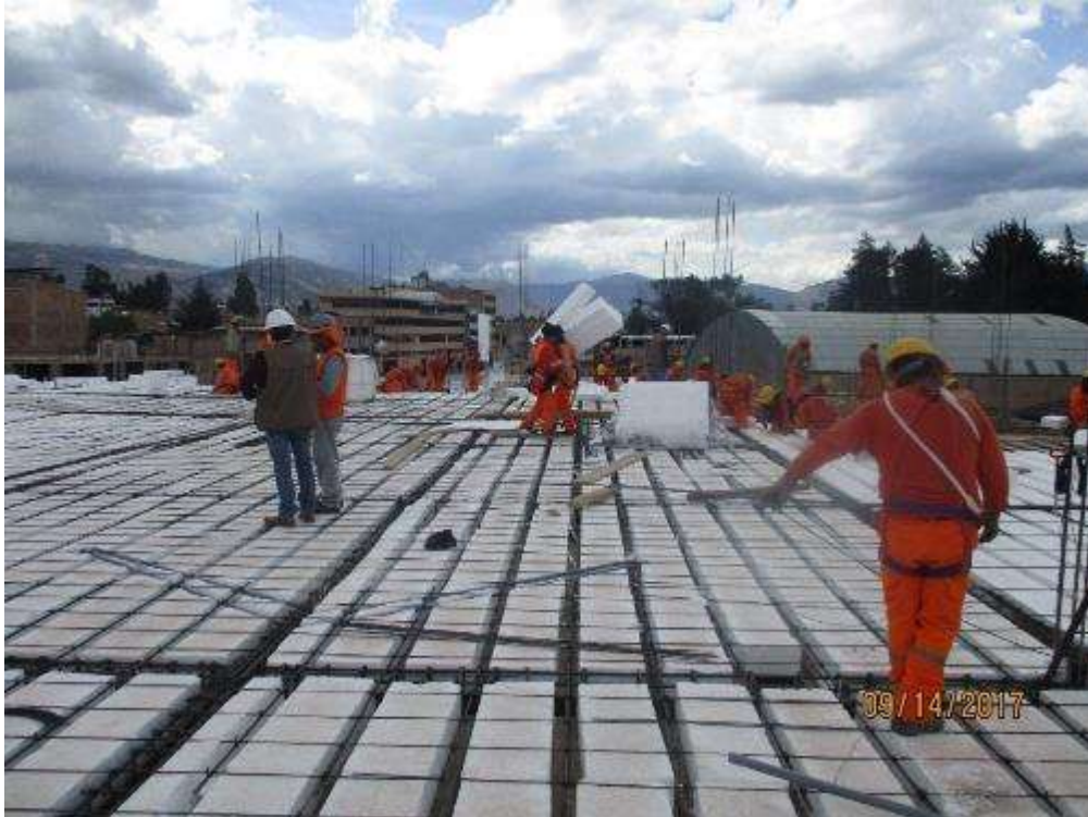
Fotografía 67. Avance de trabajos en la partida casetones en losas aligeradas.
