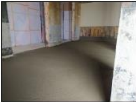
FALSO PISO DE CONCRETO f'c=175\text{kg/cm}^2 .
