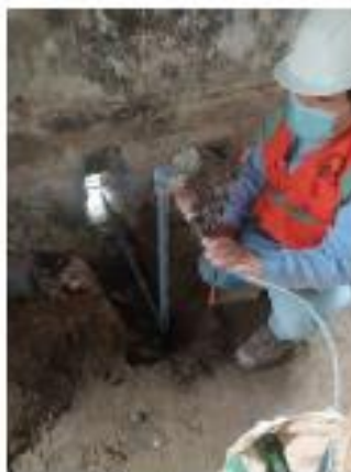
CANALIZADO ACOMETIDA ELÉCTRICA NORMAL Y EMERGENCIA
