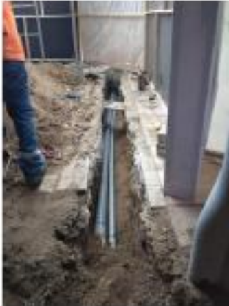
CANALIZADO ACOMETIDA COMUNICACIONES
