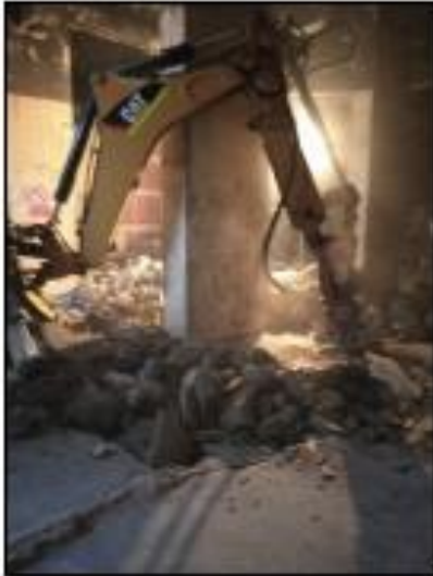
DEMOLICIÓN DE LOSA
