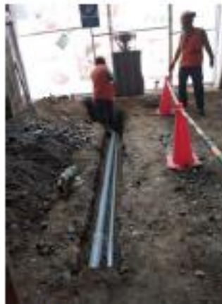
CANALIZADO ACOMETIDA ELÉCTRICA NORMAL Y EMERGENCIA
