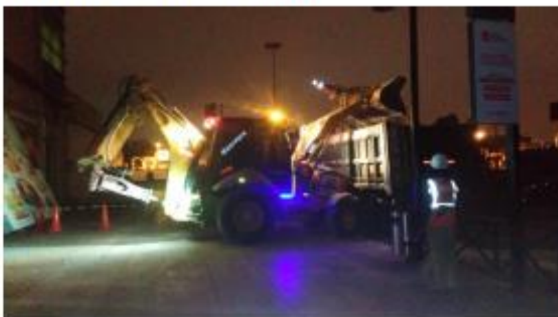
ELIMINACIÓN DE ESCOMBROS GENERADOS
