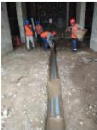
CANALIZADO ACOMETIDA ELÉCTRICA NORMAL Y EMERGENCIA
