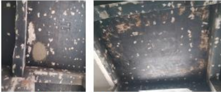
RETIRO DE ALAMBRES Y RESANES EN TECHO
