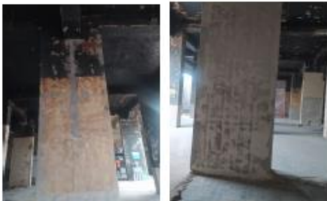
RESANES EN TABIQUES Y EN MUROS
