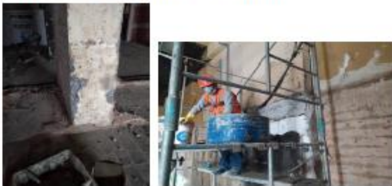
RESANES EN TABIQUES Y EN MUROS
