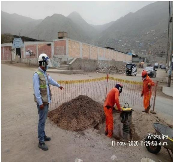
*Figura 29 Relleno y compactación de base con material afirmado para tapado de conexiones domiciliarias*
