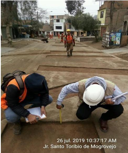
*Figura 31 Verificación de espesor de veredas para reposición de concreto en conexiones*
