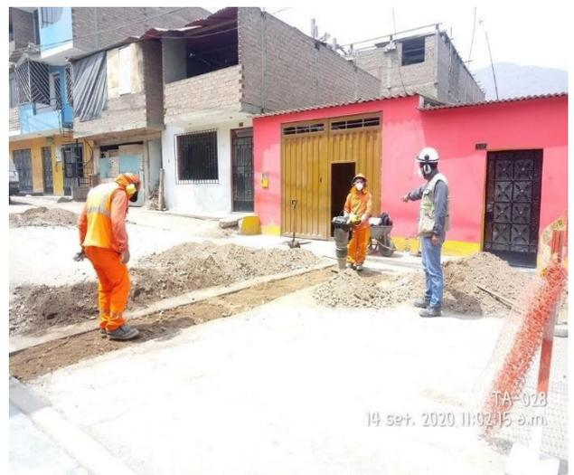
*Figura 30 Verificación de espesor para reposición de carpeta asfáltica en ventana de fragmentación*
