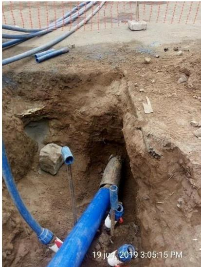
*Figura 25 Llegada de tubería del lanzamiento de máquina de fragmentación*
