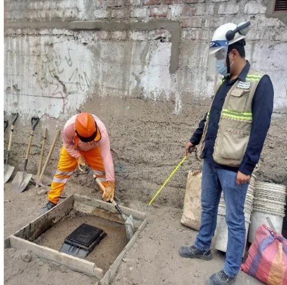
*Figura 32 Prueba de compactación con densímetro nuclear*
