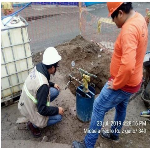
*Figura 34 Verificación de la desinfección del tramo*
