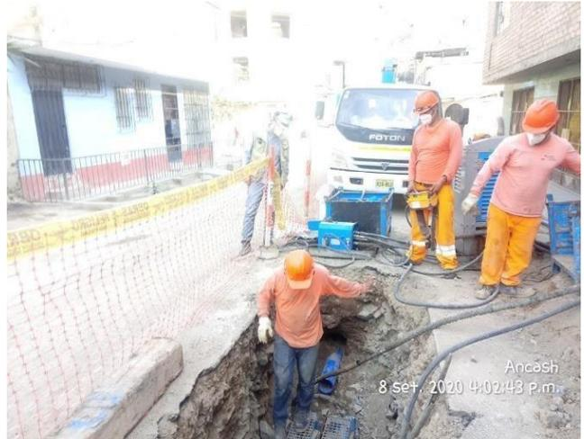
*Figura 26 Instalación de caja termoplástica de agua potable*
