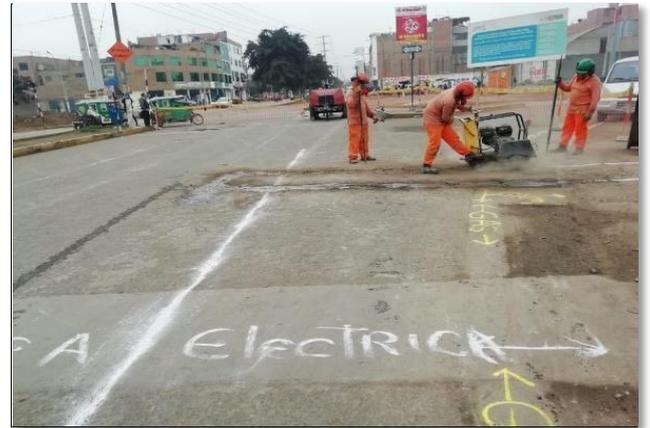
*Figura 20 Excavación de ventana de fragmentación y conexiones de alcantarillado, debidamente señalizado.*
