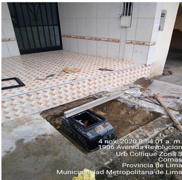
*Figura 27 Instalación de conexión de agua potable (abrazadera de toma en carga 2 cuerpos con perforador/obturador)*
