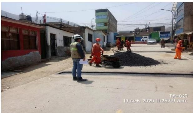
*Figura 36 Relleno y compactación de base con material afirmado para tapado de zanja*
