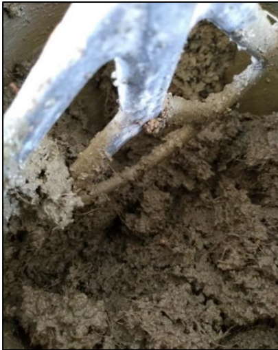
Fotografía N°73: Proceso de homogenizado de mezcla.
