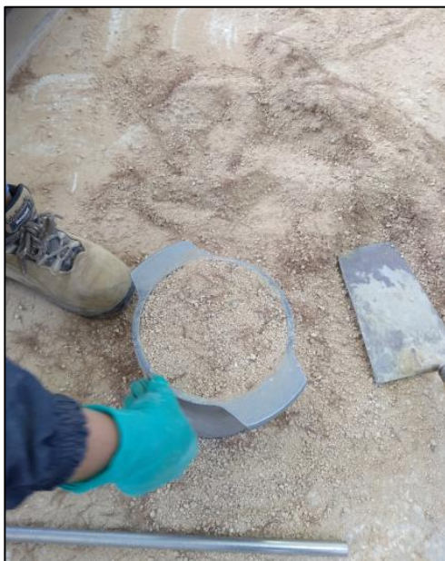
Fotografía N°31: Proceso de colocación de mezcla homogenizada con su debida compactación.
