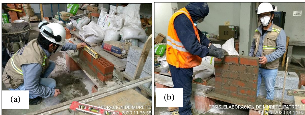
Figura 17. (a) Revisión de alineado de ladrillos con nivel de mano; (b) Finalizado del asentado de ladrillos para murete (0.60m*0.60m).
