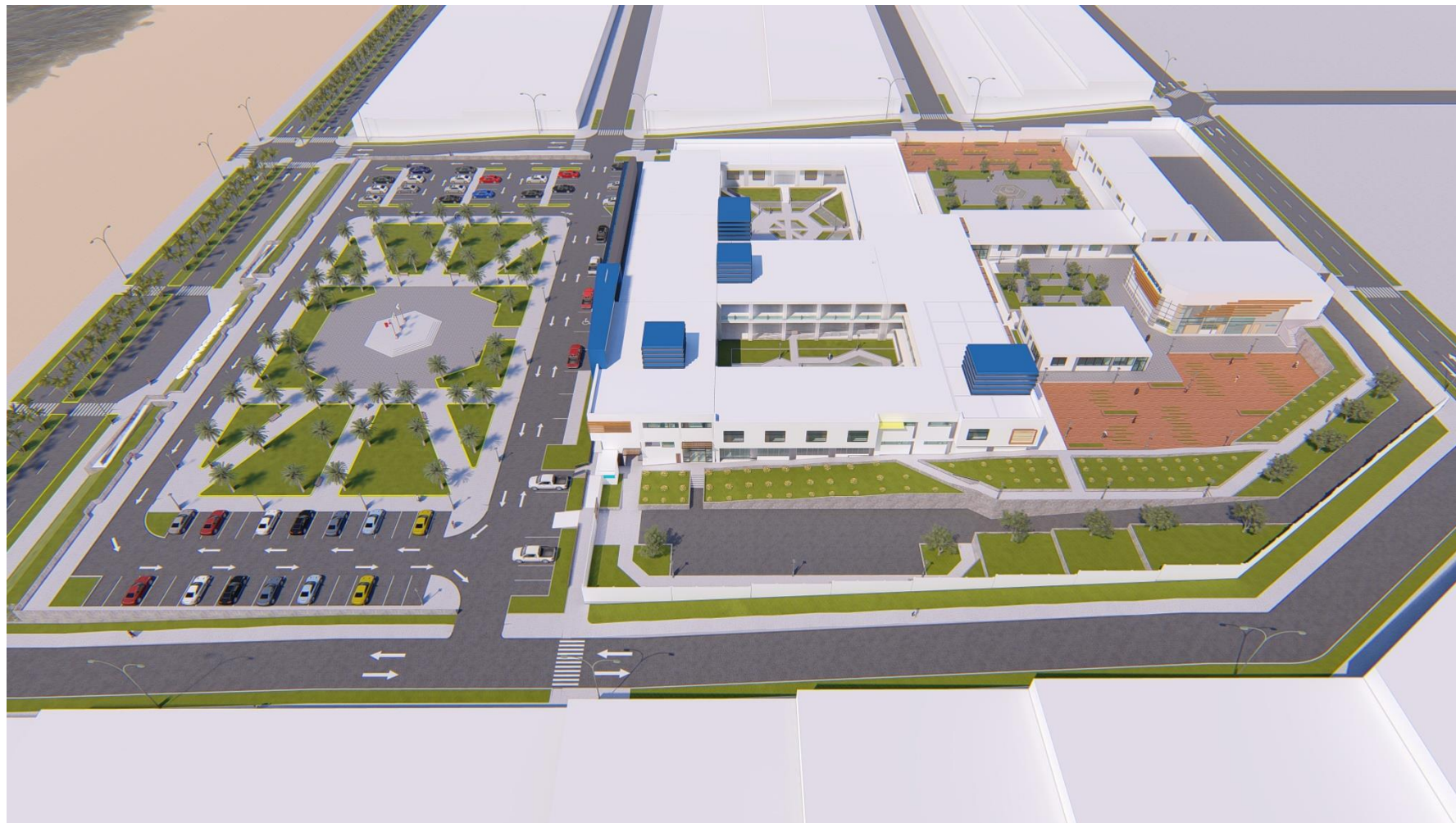
Figura N°66 Vista general lateral derecho del proyecto
