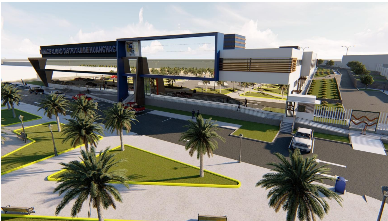
FIGURA N°77 VISTA EXTERIOR DEL PROYECTO FACHADA LADO DERECHO CON APLICACIÓN DE MURO CORTINA Y VIDRIO REFLEJANTE 50% DE TRANSMISIÓN)
