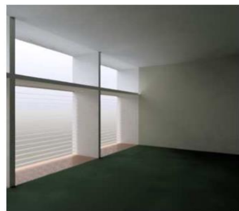
Fig. 4 Light shelf con cielo nublado con película especular de alta reflectancia Fuente: www.london.uk.lightshelves/main.html
