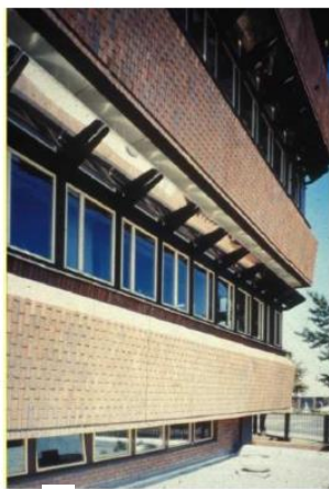
Fig. 5. Utilización en la fachada del light shelf en oficinas.
