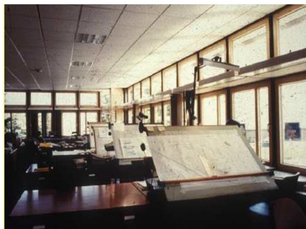
Fig. 6. Vista del interior de la oficina con el uso del light shelf www.londonmet.ac.uk/lightshelves/main.html
