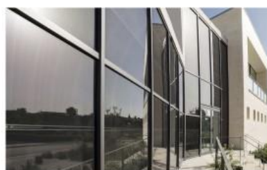
Uso de vidrio fotovoltaico en vanos
