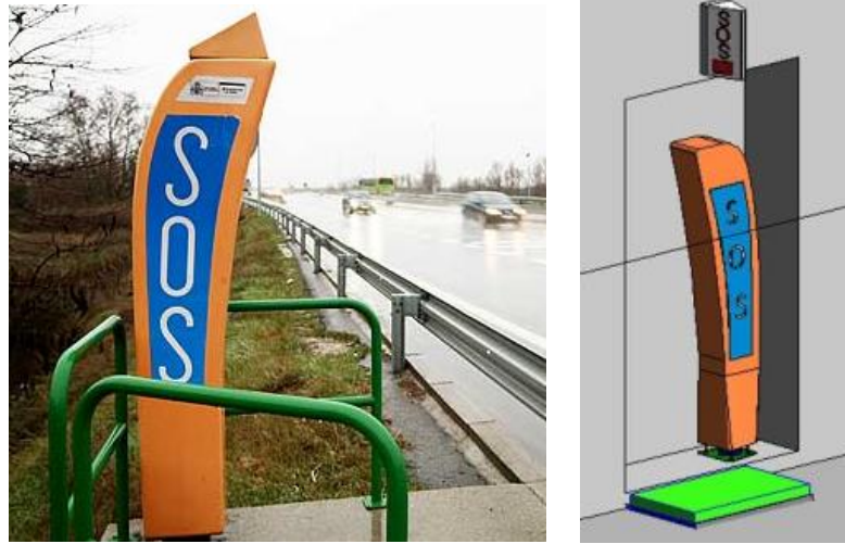
Figura N° 33: Ejemplo de postes SOS exterior al túnel
