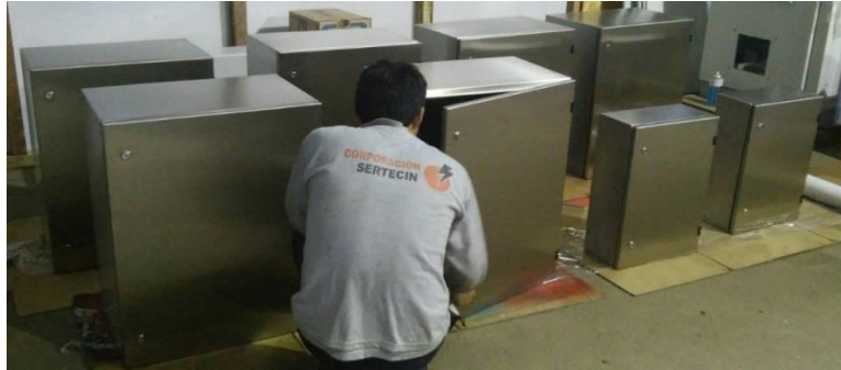
Figura 16. Ensamblado del gabinete para tablero eléctrico
